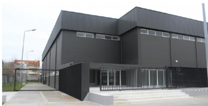
Figura 3 - Entrada do Pavilhão Municipal da Senhora da Hora.
