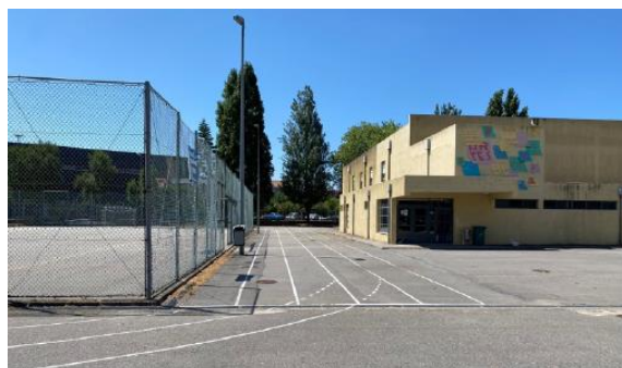
Figura 7 - Pista de Atletismo exterior da ESSH.
