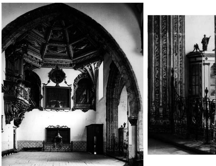
Figura 13 – Uma estrutura de madeira e vidro posicionada na capela (parede oeste)
