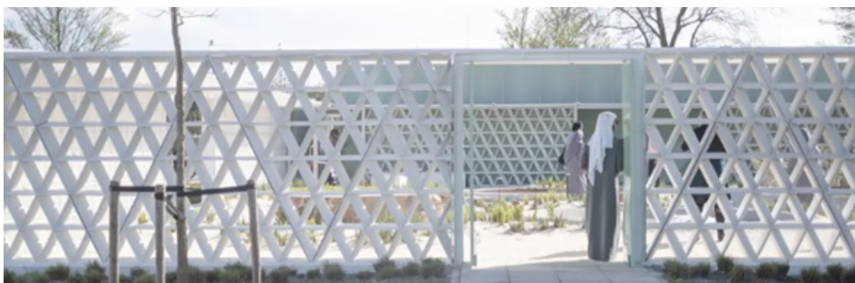
Figura 39 – Fachada do Pavilhão dos Emirados Árabes Unidos impresso em 3D (Aectual, 2022).
