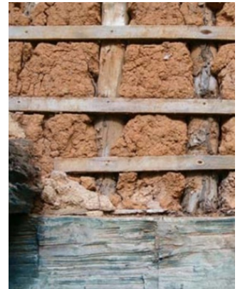
Figura 18 – Construção em Tabique (Olender, 2006).
