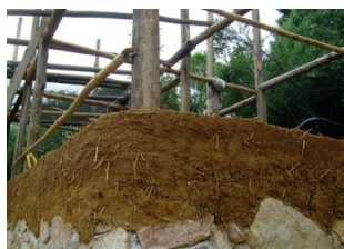
Figura 16 – Construção em Cob (Coimbra, 2017).
