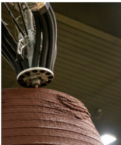
Figura 40 – Processo de impressão do projeto MARSHA da AI SpaceFactory reproduzida em (Walsh, 2019).
