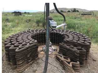
Figura 33 – Processo de impressão do projeto Mud Frontiers: Part II (Emerging Objects, 2019).
