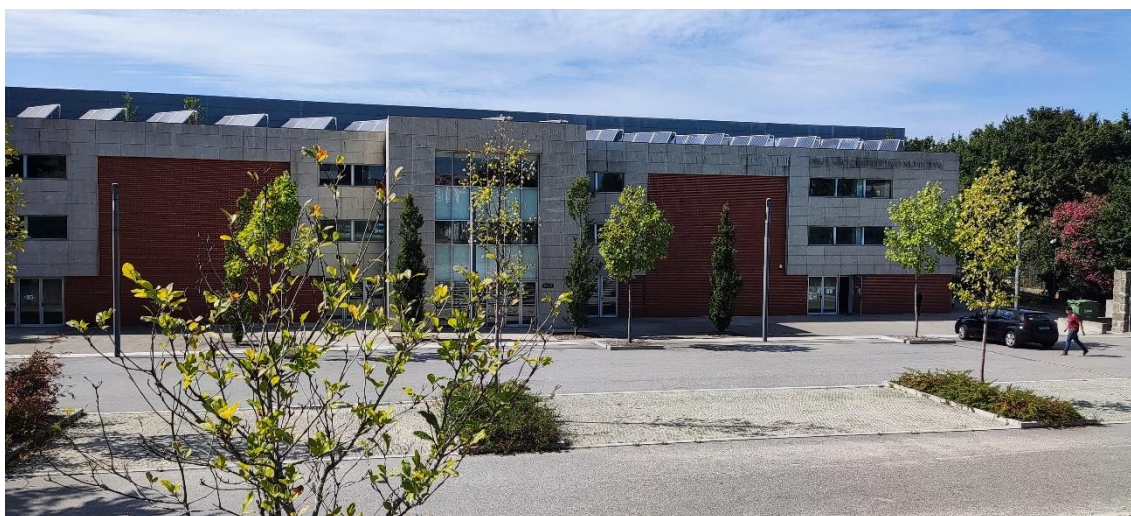
Figura 3 – Pavilhão Municipal de Gaia
