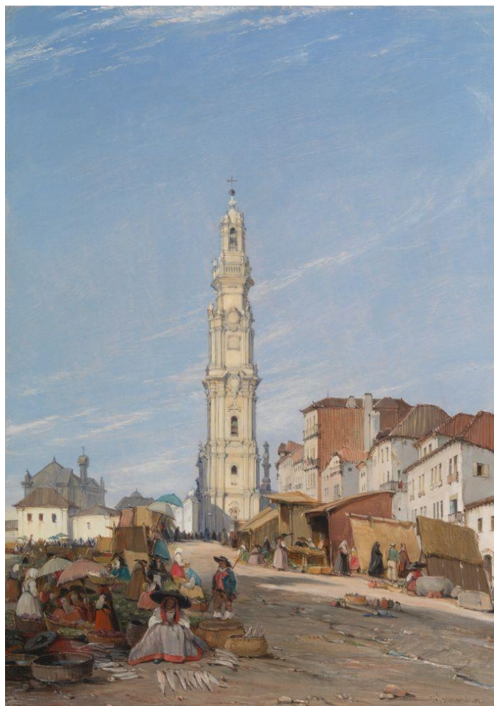
Figura 29 - Torre dos Clérigos (1837)
