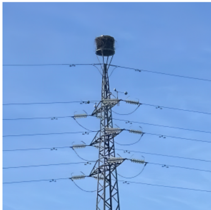
Figura 2.26: Ilustração de uma plataforma de nidificação[23]
