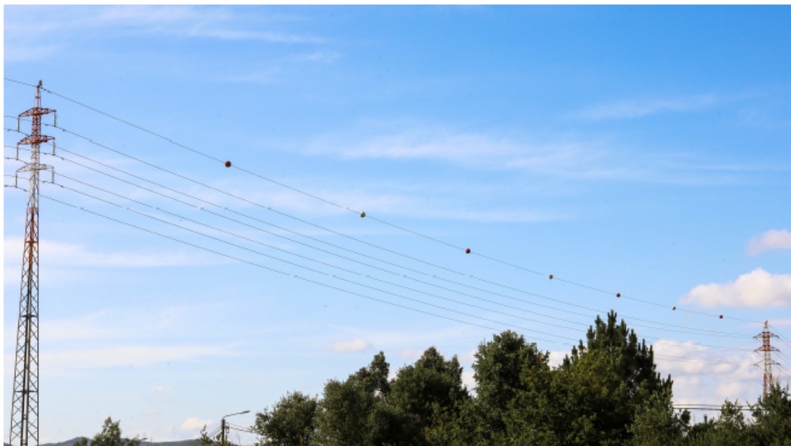
Figura 2.21: Balizagem aeronáutica diurna [23]
