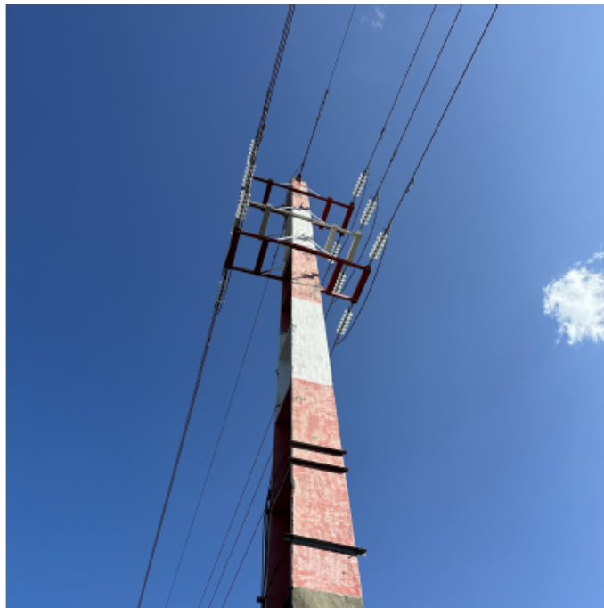
Figura 2.16: Apoio com função de reforço de alinhamento [23]
