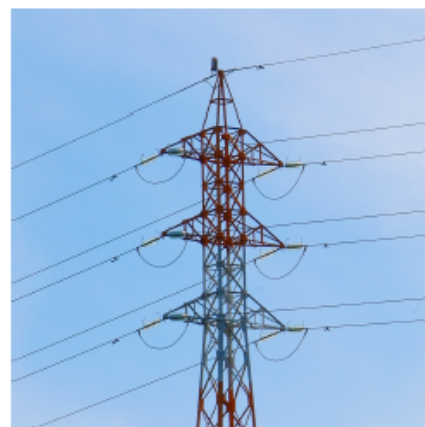
Figura 2.12: Ilustração de uma cadeia de amarração [23]
