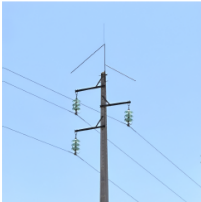
Figura 2.25: Ilustração de uma seta assimétrica de anti-nidificação[23]
