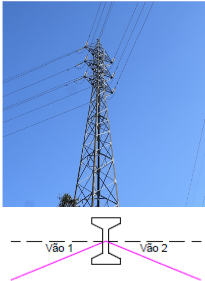
Figura 2.15: Apoio com função de ângulo [23]
