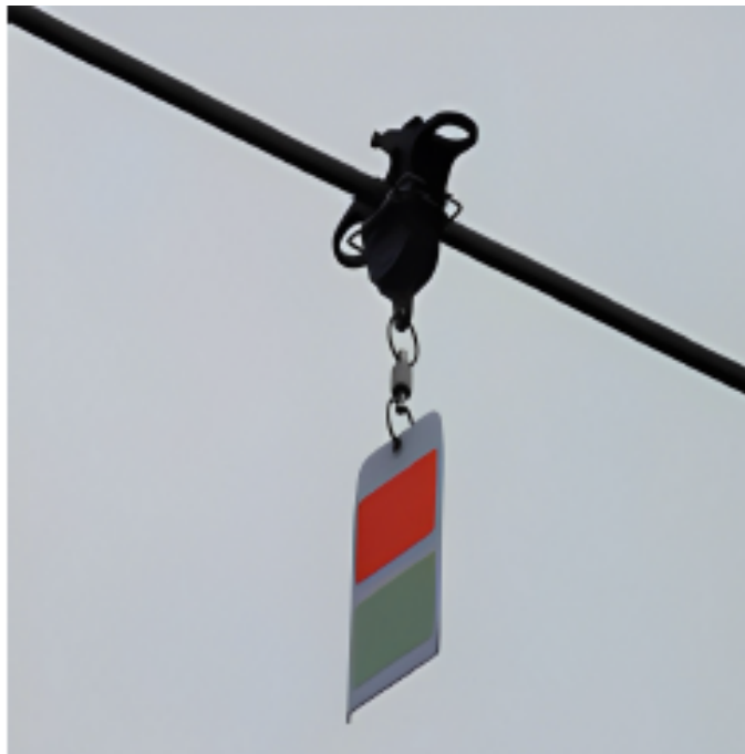
Figura 2.22: Ilustração de um Firefly Bird Flappers [23]
