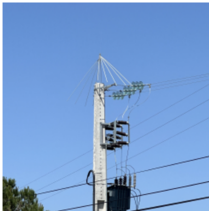
Figura 2.24: Ilustração de um guarda-chuva de anti-nidificação[23]
