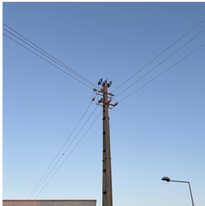
Figura 2.17: Apoio com função de reforço de derivação em alinhamento[23]
