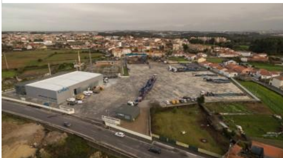
Figura 2- Instalações da LASO Transportes no Norte
