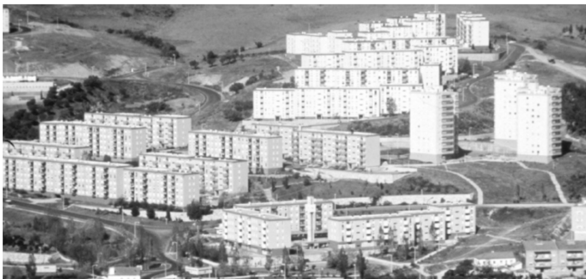
Fig. 4.5.1.1 – Santo António dos Cavaleiros, Lisboa, Edifícios de habitação construídos pela empresa ICESA – Sistema FIORIO
