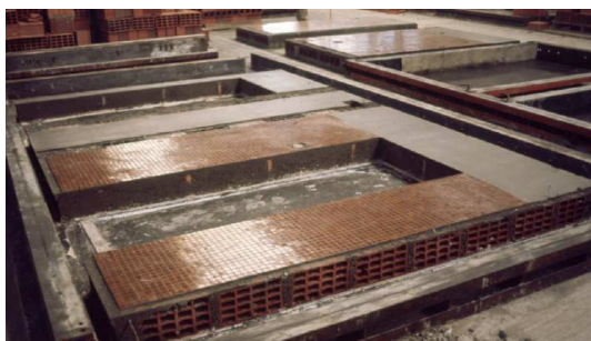
Fig. 4.5.1.4 – Pré-fabricação de parede resistente interior com vão e acabamentos já aplicados
