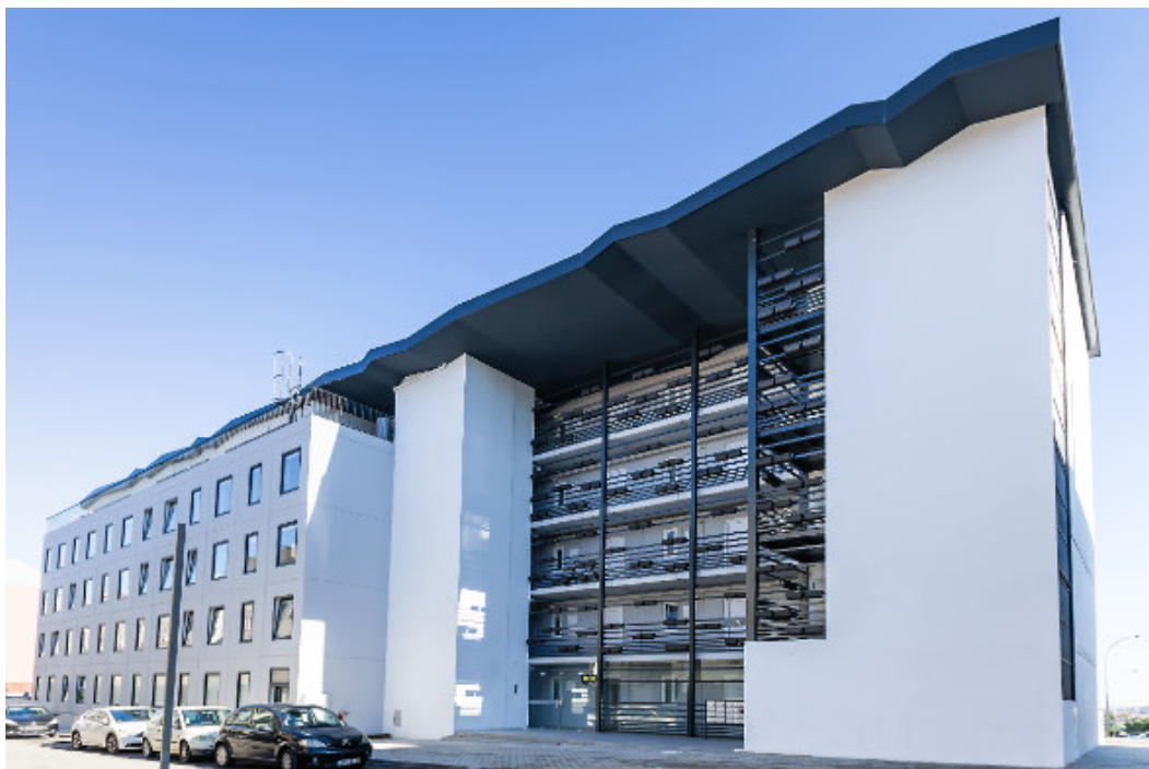
Fig. 4.5.2.7 – Residência social da PSP na Amadora – Construção pré-fabricada com sistema modular SIMBA. Obra concluída no ano 2023
