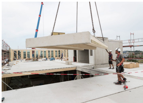
Fig. 4.5.3.4 – B&B Guimarães – Construção híbrida utilizando o sistema construtivo CREE, montagem dos elementos das lajes de piso em madeira.
