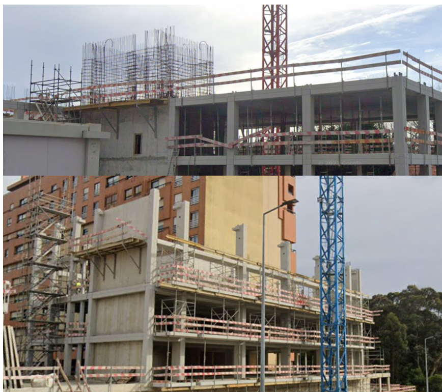
Fig. 4.5.2.1 e 4.5.2.2 – Construção com estrutura pré-fabricada: pilares, vigas, lajes e construção tradicional nos pisos enterrados, núcleo de elevadores e escadas – Edifício de habitação multifamiliar, THE YARD em Vila Nova de Gaia
