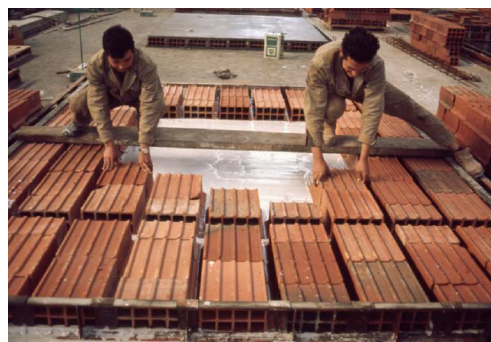
Fig. 4.5.1.3 – Pré-fabricação de laje
