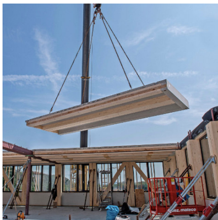
Fig. 4.5.3.4 – B&B Guimarães – Construção híbrida utilizando o sistema construtivo CREE, montagem dos elementos das lajes de piso em madeira.
