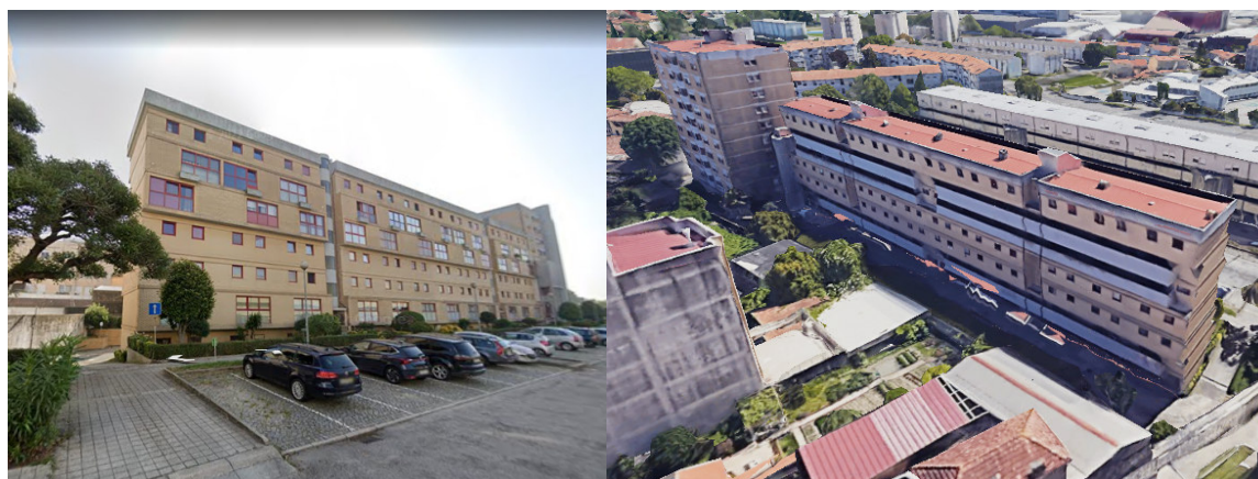
Fig. 3.4.3 e 3.4.4 – Fachada Principal (entradas nos edifícios) e Fachada Posterior (galerias exteriores de acesso à habitação), Edifício com 72 habitações construído em 1994, promotora a Cooperativa de Habitação HABECE, Viso, Porto.
