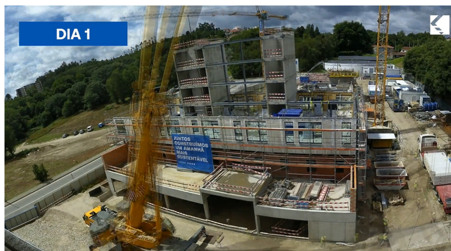
Fig. 4.5.3.2 – B&B Guimarães – Construção híbrida utilizando o sistema construtivo CREE, primeiro dia dos trabalhos da montagem dos elementos de madeira.
