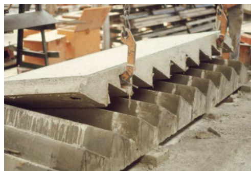
Fig. 4.5.1.5 – Pré-fabricação de escadas
