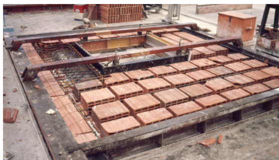
Fig. 4.5.1.2 – Pré-fabricação de parede resistente exterior com vão
