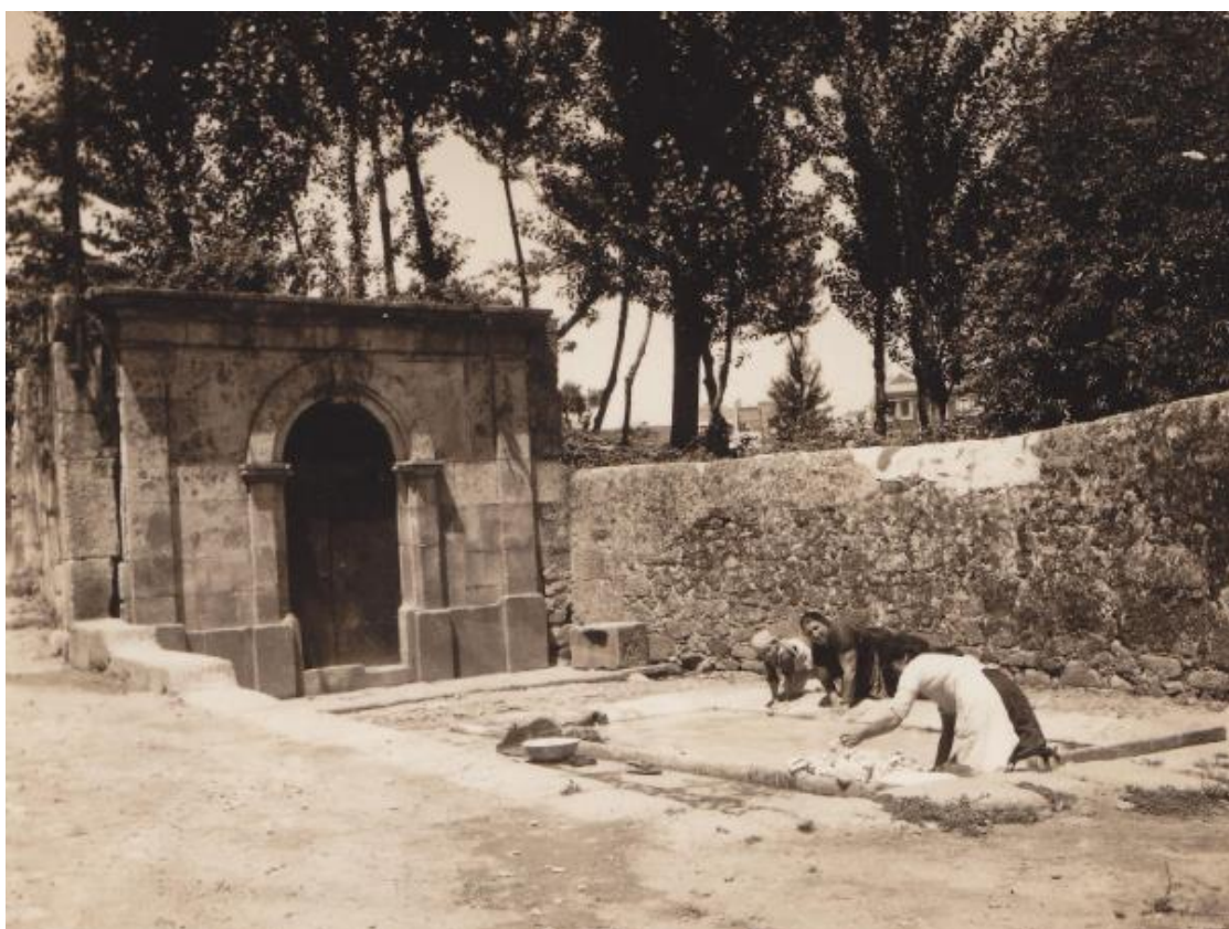
Figura 14: Fonte do Campo Alegre. Junto da porta vê-se a abertura por onde passa o braço da bomba que tinha sido tirada na ocasião da foto. Fotografia retirada do trabalho de Bahia Júnior, 1909.
