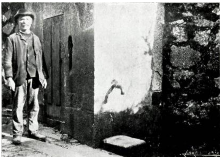
Figura 14: Fonte do Campo Alegre. Junto da porta vê-se a abertura por onde passa o braço da bomba que tinha sido tirada na ocasião da foto. Fotografia retirada do trabalho de Bahia Júnior, 1909.
