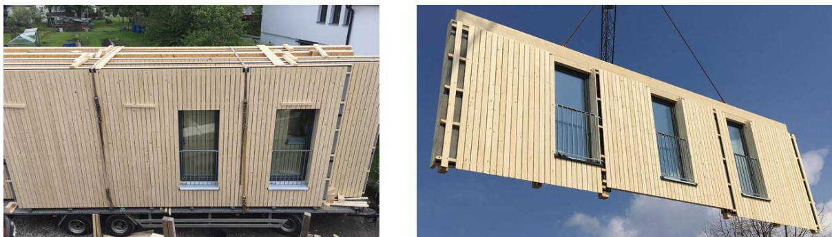
Figura 26 - Paredes exteriores de um edifício LCT [31].
