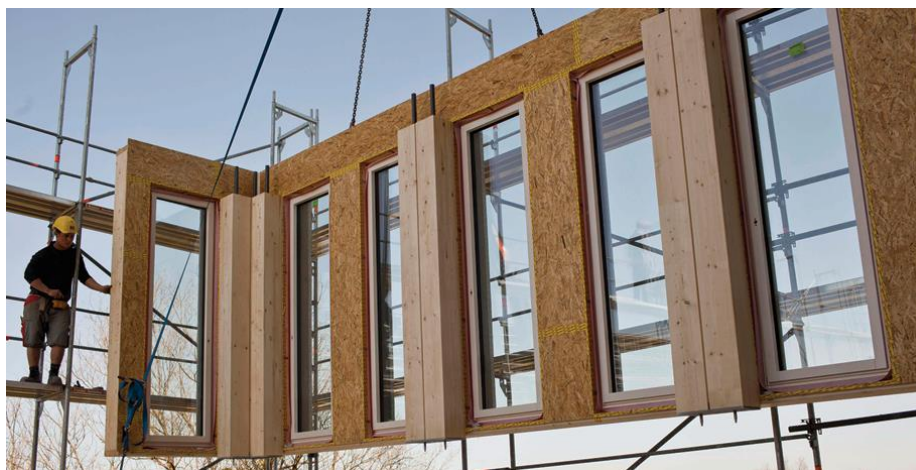
Figura 27 – Montagem dos painéis de fachada [31]
