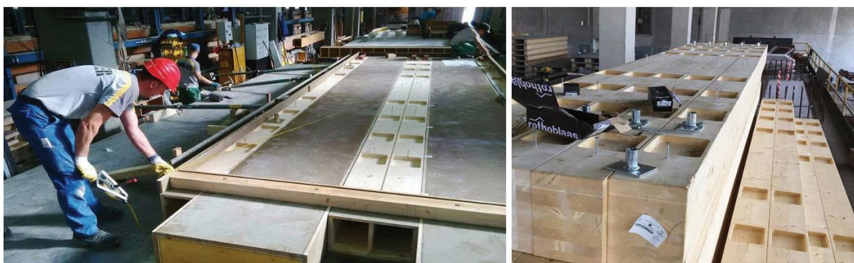
Figura 23 - Entalhes nas vigas de madeira
