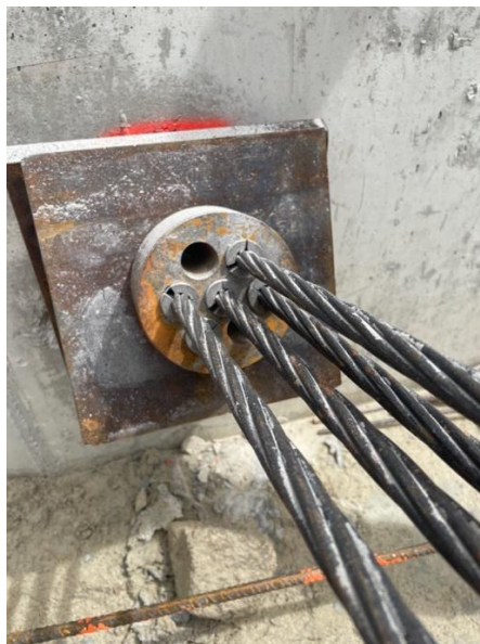
Fig. 10 – Instalação de uma ancoragem.
