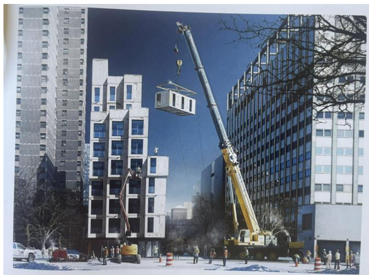
Figura 23 - Microapartamentos executados em aço, edifício residencial Carmel em NY. Fonte: Escritório NYC Mavor, retirado do livro(Dorries et. al, 2019)
