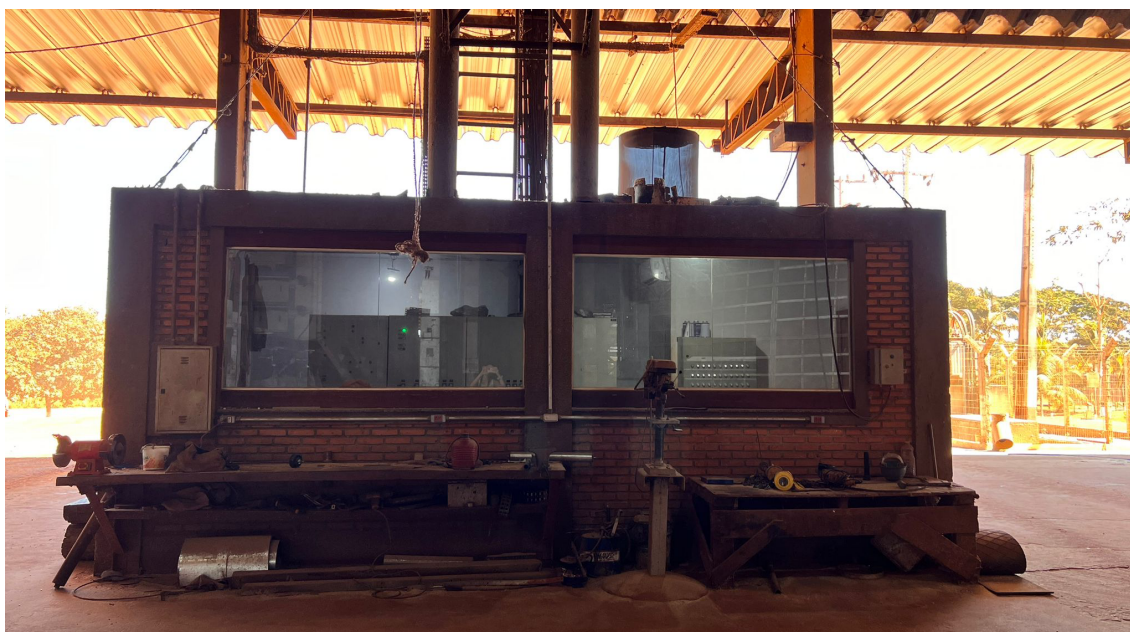
Foto 22 – Cabine de controle dos silos. Foto: Desirêe Galvão.
