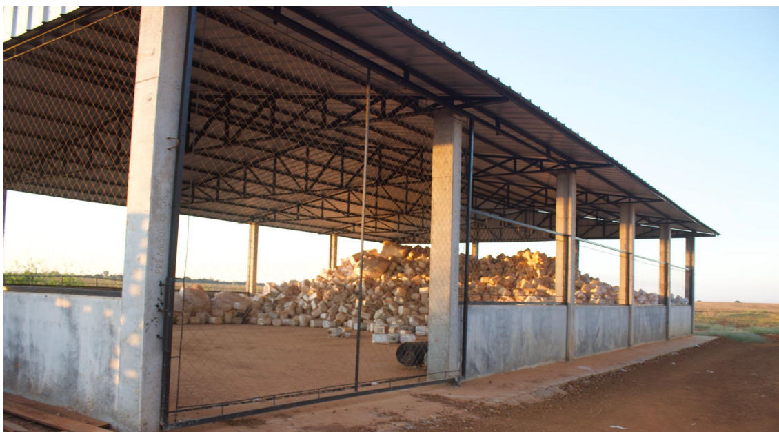
Foto 19 – Armazém das embalagens de agrotóxicos. Estas embalagens devem ter um descarte específico, previsto em normativas. A distância do armazém de embalagens para o silo e o escritório da fazenda é de 14 km. Foto: Desirêe Galvão.
