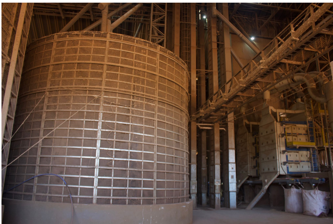
Foto 20 – Visita à estrutura do interior do silo. Foto: Desirêe Galvão.
