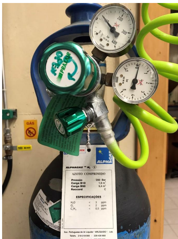
Figura 15-Garrafa de azoto de ar comprimido.
