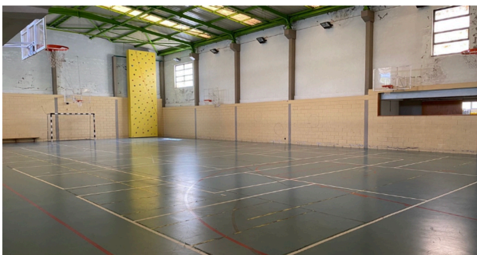
Figura 2 - Pavilhão Polidesportivo da ESSH
