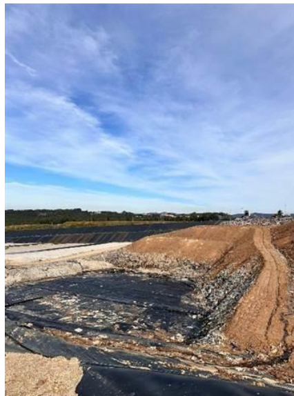
Figura 16 - Aterro sanitário de Canedo
