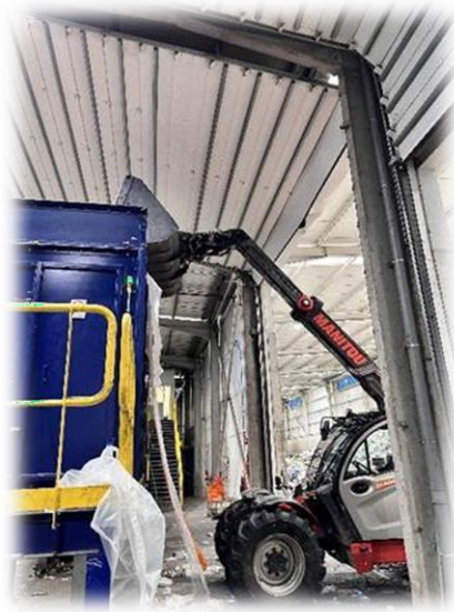
Figura 18 - Deposição dos resíduos no doseador pela máquina pá carregadora
