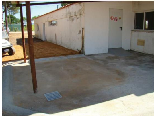
Figura 19. Exemplo de área de preparação da calda e ou limpeza de Pulverizadores, com sistema de recolha de efluentes (Fonte: DGAV, 2015).
