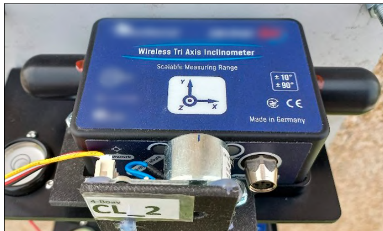
Figura 3.5: Clinómetro instalado in loco Fonte: Arêde et al. (2024)
