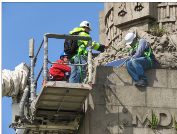
(a) Instalação de um coletor fotovoltaico
