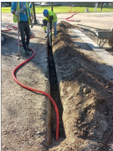
(a) Abertura das valas
