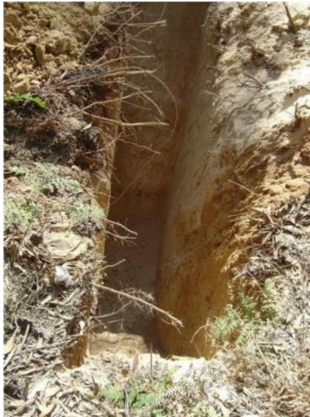
Figura 3.4 Exemplo de um poço de prospeção (Campanha de Prospeção de 2005 realizada pela IP para a Linha de Alta Velocidade Porto-Lisboa).
