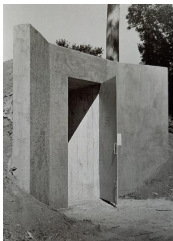
Figura 128- Entrada da instalação Travessia.
