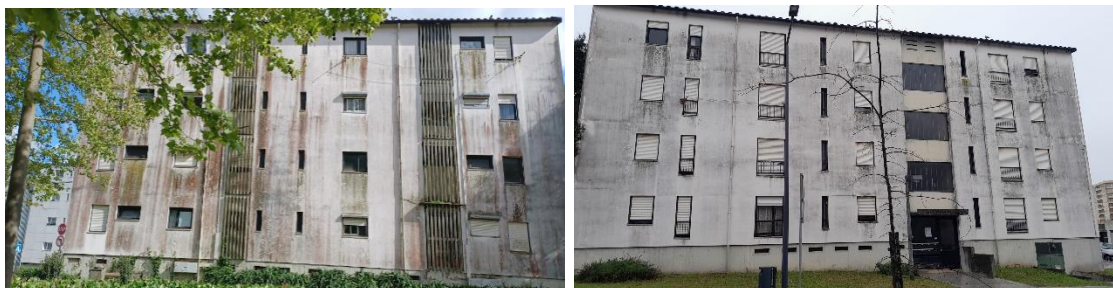
Figura 15 - Vista exterior das fachadas de um dos edifícios em estudo.
