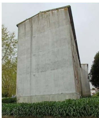
Figura 16 - Vista exterior das empenas de um dos edifícios em estudo.
