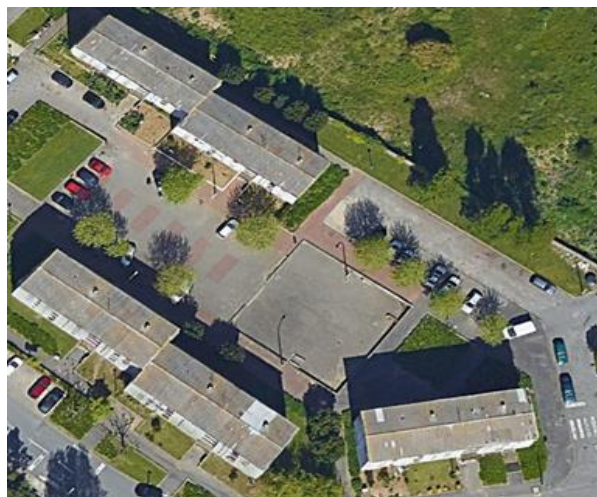
Figura 18 - Vista exterior das coberturas dos edifícios em estudo.
