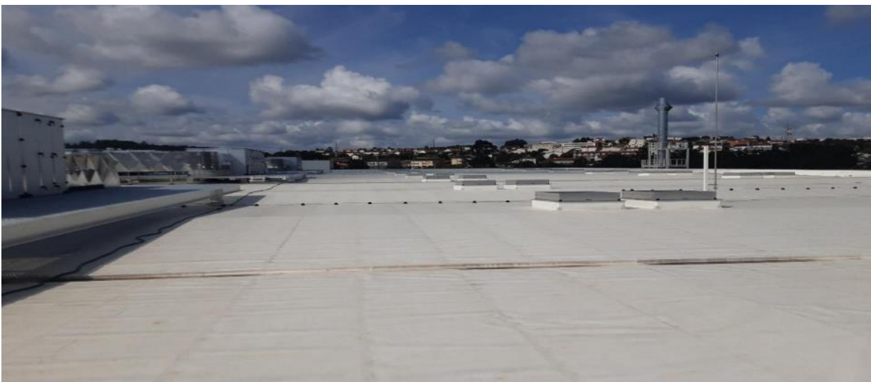
Figura 17 - Zona de Instalação de Painéis Fotovoltaicos (Fonte:Própria)
