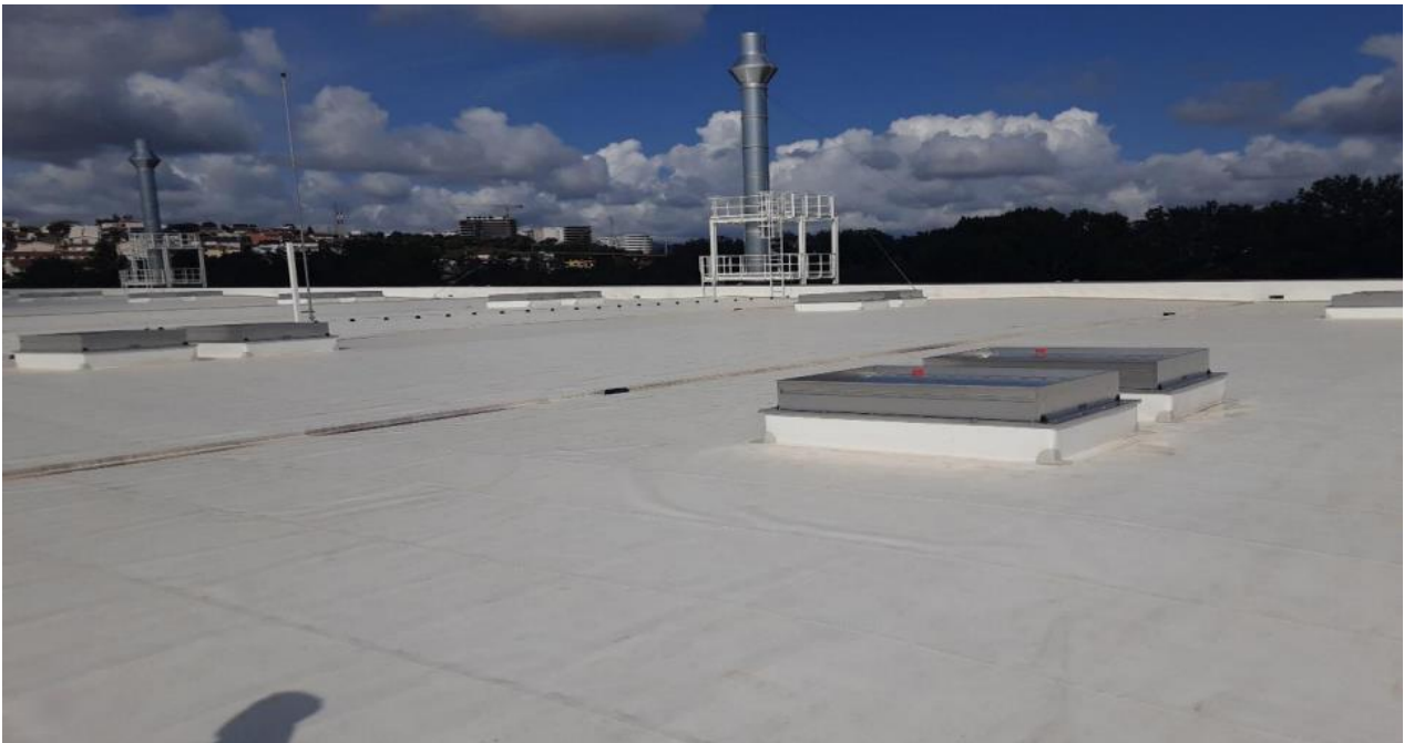
Figura 16 - Zona de Instalação dos Painéis Fotovoltaicos (Fonte: Própria)
