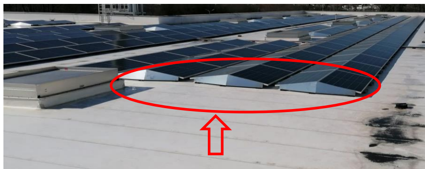
Figura 26 - Defletores de Vento na instalação PV (Fonte: Própria)
