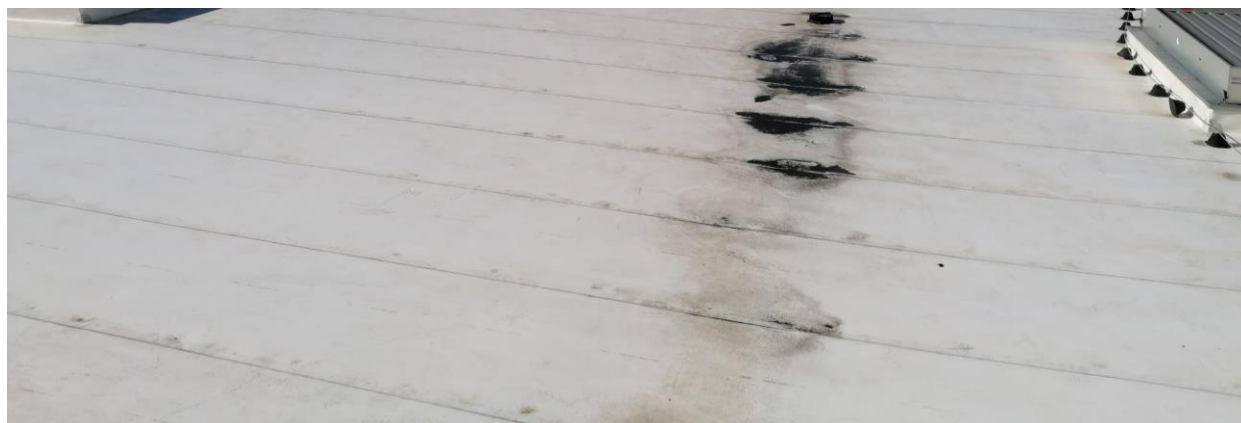
Figura 27 - Cobertura do Caso de Estudo (Fonte: Própria)
