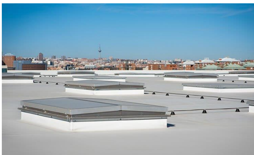
Figura 38 - Exemplo de Exutor de fumos (TRIA, 2024)
