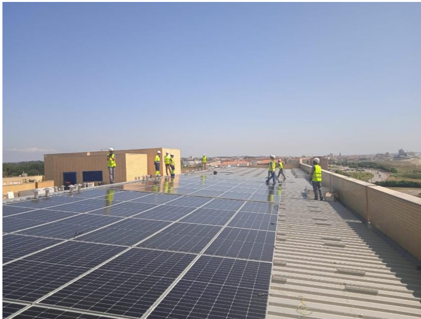
Figura 3 - Instalação de Painéis em Cobertura (Fonte: Própria)
