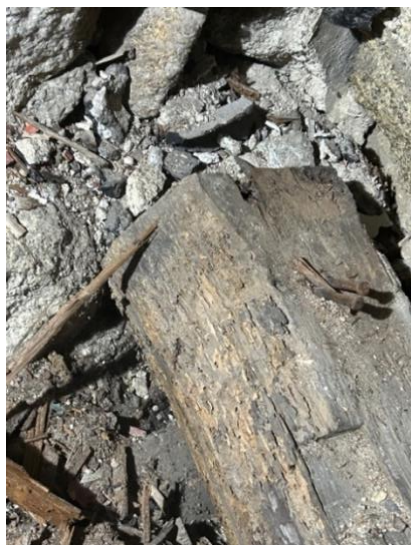
Legenda 4. 13 - Viga 1, piso 2, zona 1 (lado direito), com ataque de insetos de ciclo larvar.
