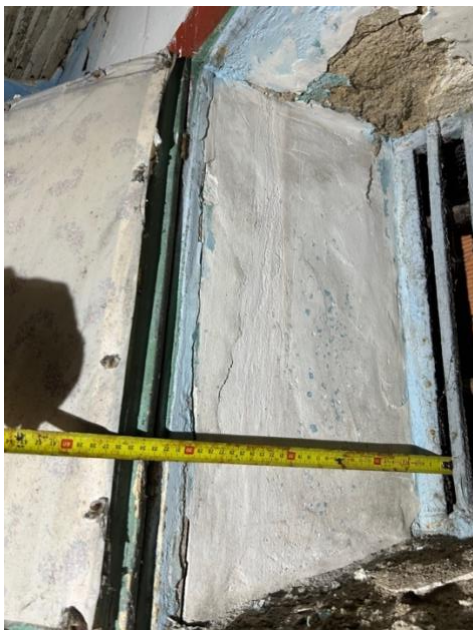
Legenda 3. 17 - Parede exterior em alvenaria de pedra de granito.
