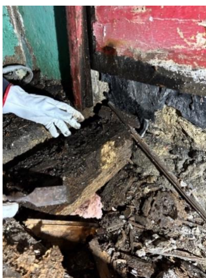
Legenda 4. 12 - Viga 1, piso 2, zona 1 (lado esquerdo), com ataque de insetos de ciclo larvar.
