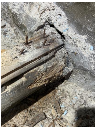
Legenda 4. 15 - Viga 2, piso 2, zona 2 (lado esquerdo), com ataque de insetos de ciclo larvar.
