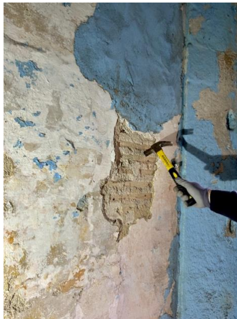
Legenda 3. 16 - Parede de compartimentação em tabique.
