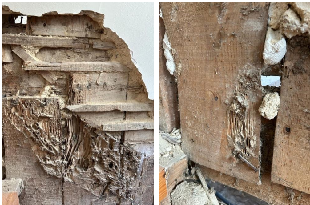
Legenda 2. 11 - Ataque de térmitas nos elementos de madeira, secção longitudinal.
