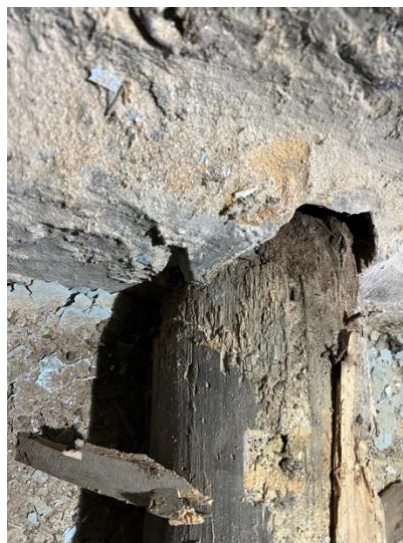
Legenda 4. 14 - Viga 4, piso 2, zona 2 (lado esquerdo), com ataque de insetos de ciclo larvar.
