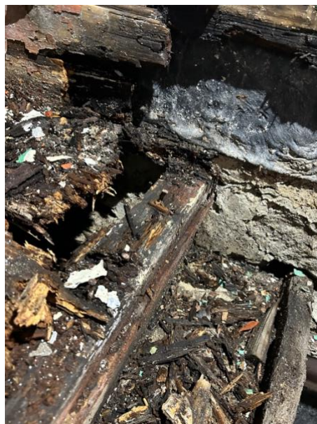
Legenda 4. 2 - Viga 3, piso 3, zona 1 (lado direito), verifica-se infiltração de água.
