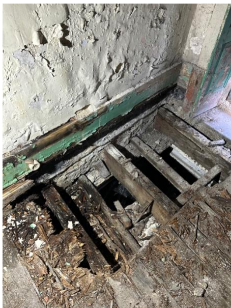
Legenda 4. 2 - Viga 3, piso 3, zona 1 (lado direito), verifica-se infiltração de água.
