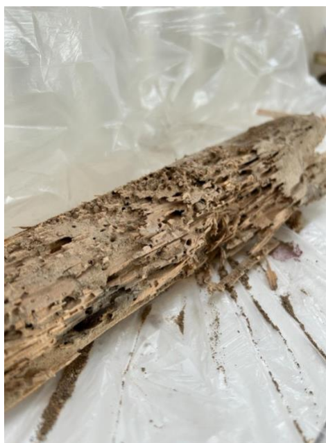
Legenda 2. 9 - Presença de Caruncho nos elementos de madeira.
