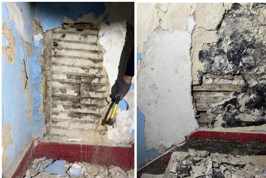
Legenda 3. 20 - Estrutura da caixa de escadas interiores.
