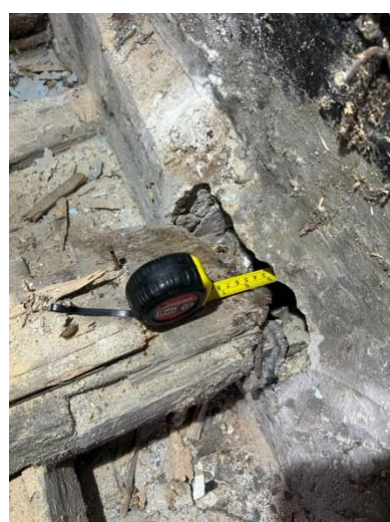
Legenda 4. 7 - Viga 3, piso 2, zona 2, com presença de fungos de podridão e perda de secção no apoio.
