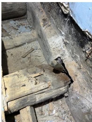
Legenda 4. 7 - Viga 3, piso 2, zona 2, com presença de fungos de podridão e perda de secção no apoio.
