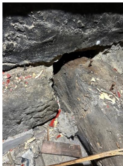
Legenda 4. 11 - Viga 6, piso 2, zona 1 (lado esquerdo), com ataque de insetos de ciclo larvar.
