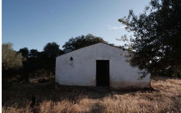
Figura 4.10 – Fotografia do edifício existente (Caleiro, 2022).
