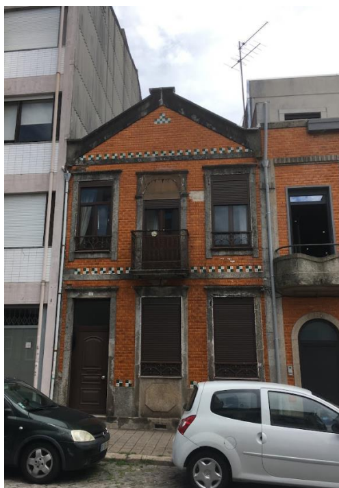
Figura 4.1 – Fachada principal do edifício existente (Ferreira, 2021).
