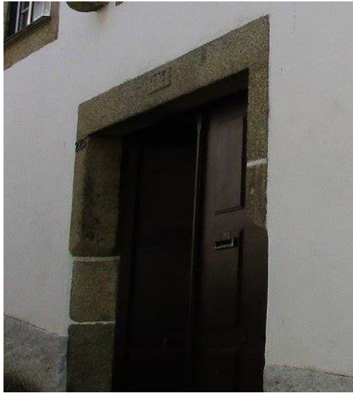
Fig. 8. Parte inferior das ombreiras com esquinas boleadas, para facilitar entrada de carro dos bois (Fot. Inês Lopes, 2023)
