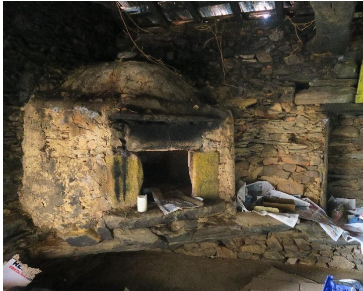
Fig. 17. Interior de uma cozinha, com forno e copeiras. Exemplo de utilização de placas de lousa como elementos estruturais dos vãos (Fot. Inês Lopes, 2023)
