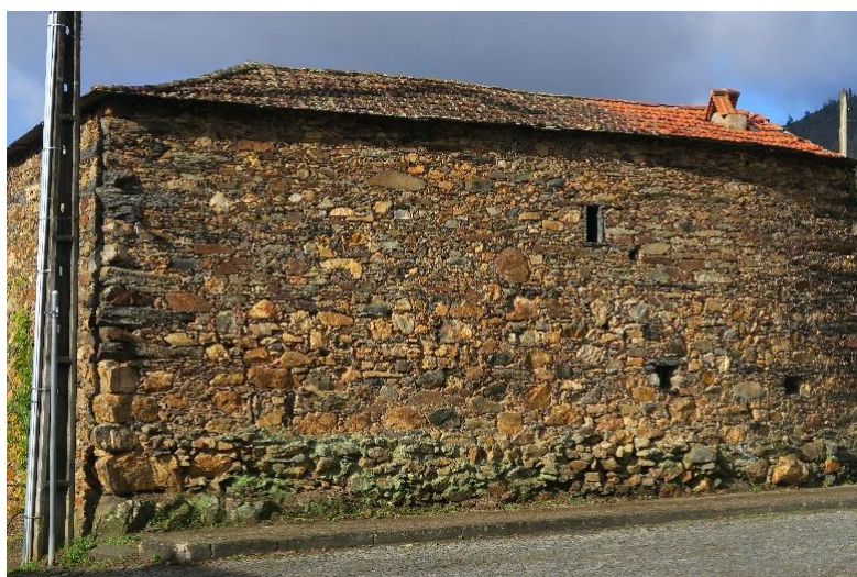
Fig. 14. Fachada cega de casa de lavoura, em xisto de várias tonalidades, na qual se abre apenas uma estreita fresta (Fot. Inês Lopes, 2023)
