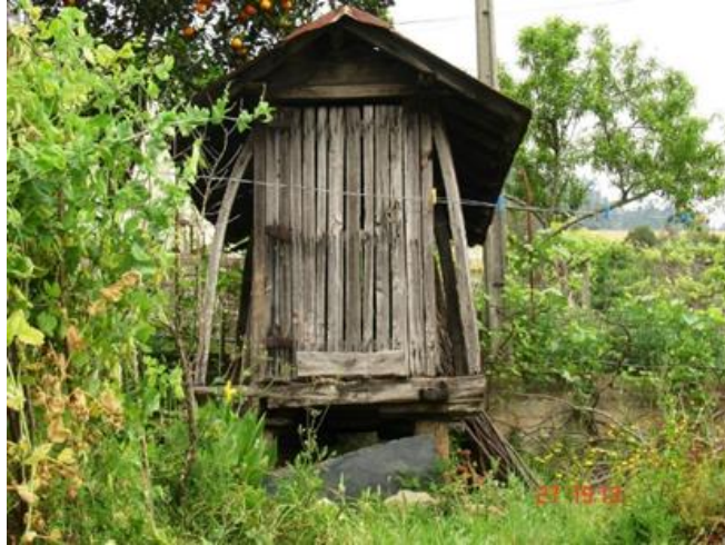
Fig. 19. Espigueiro com estrutura em madeira (Fot. Inês Lopes, 2023)
