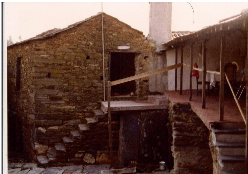
Fig 13. Casa da Moreirinha, varanda apoiada em prumos, e com soalho, ambos em madeira. O acesso à varanda e ao sobrado é feito pelas escadas capeadas com placas de xisto (Fot. Inês Lopes, 2023)
