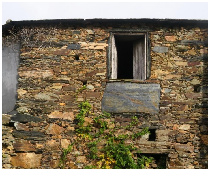
Fig. 16. Fachada em xisto, com pedra de dimensões e coloração diversificadas. A abertura da janela está apoiada num grande bloco quadrangular em xisto, que lhe serve de soleira. A padieira é modesta, uma vez que a janela quase toca no beiral (Fot. Inês Lopes, 2023)
