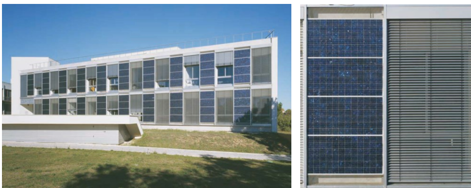
Figura 4 – Fachada Sul e Aproximação ao módulo fotovoltaico - Edifício Solar XXI. (fonte: LNEG, 2010)
