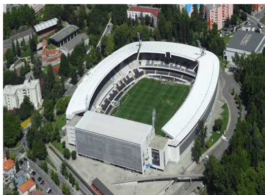
Figura 3 - Estádio D. Afonso Henriques.
