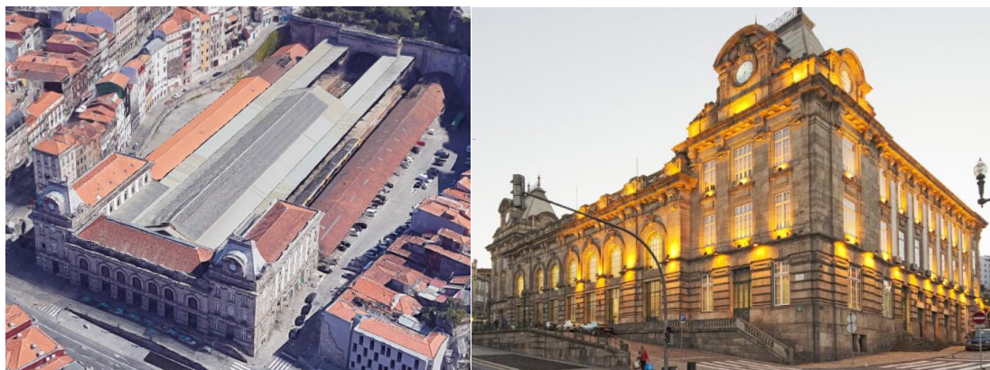
Figura 3.1 – Fotografias aérea (à esquerda, Fonte: Google Earth) e terrestre (à direita, Fonte:[52]) da estrutura da Estação de São Bento.
