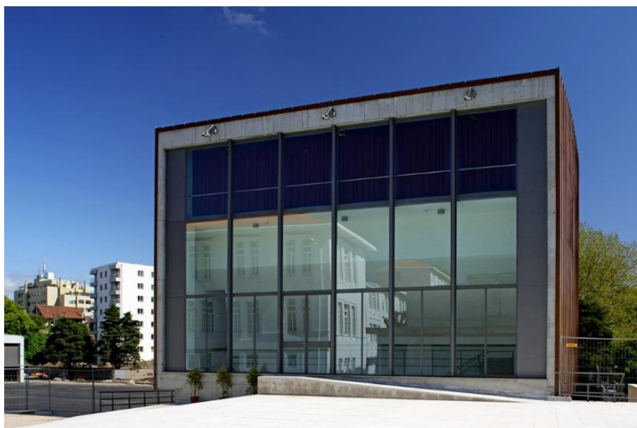
Fig. 4.2 - Edifício Novo do Conservatório de Música do Porto [42]
