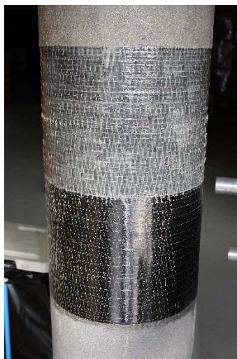
Fig. 16 – Execução de um encamisamento de um pilar com FRP [13]
