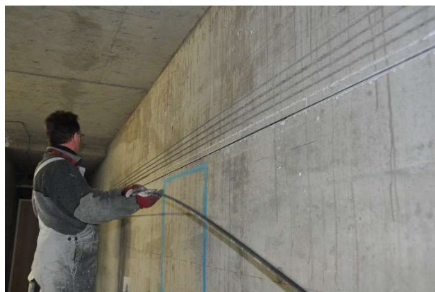
Fig. 17 – Execução de uma inserção de laminados de FRP no betão [13]
