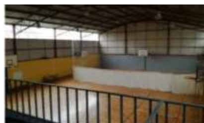
Figura 4: Pavilhão de "cima" com dois espaços
