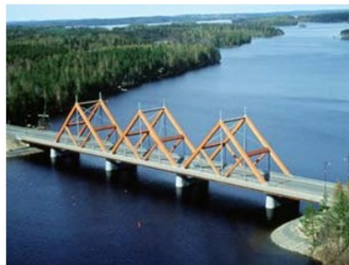
Figura 2.18 - Ponte Vihantasalmi, Finlândia, 1999 (construída em MLC) [27]
