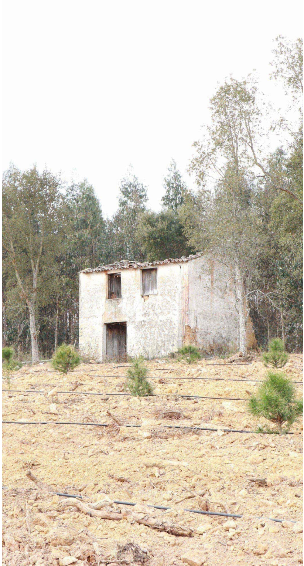
Fig 34. Ruína atual no terreno da Samada.
