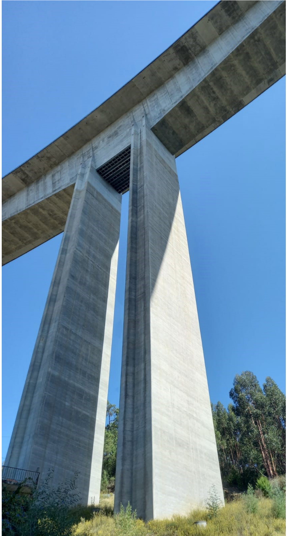
Fig 60. Ponte sobre o rio Ceira.
