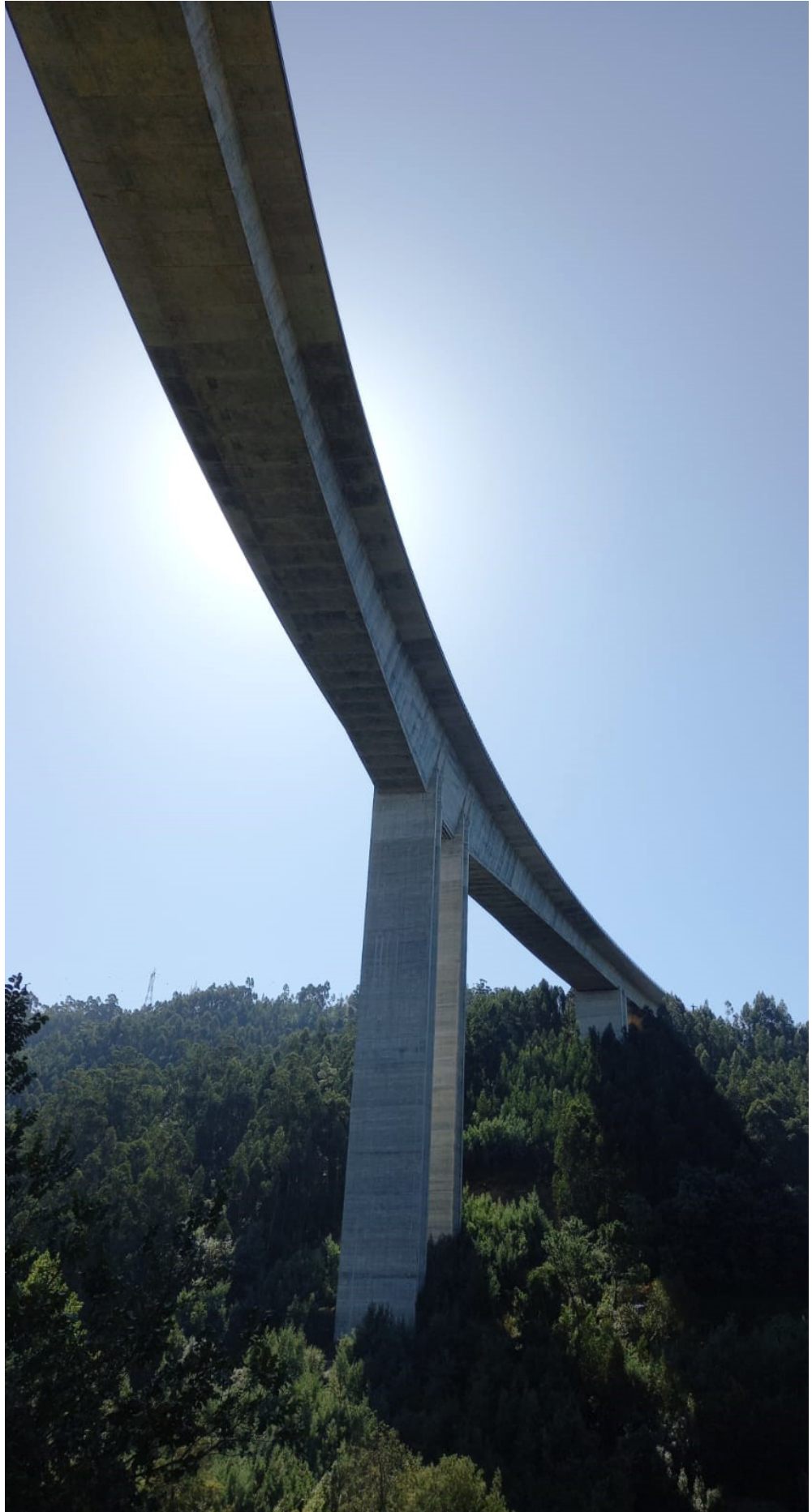
Fig 56. Ponte sobre o rio Ceira.
