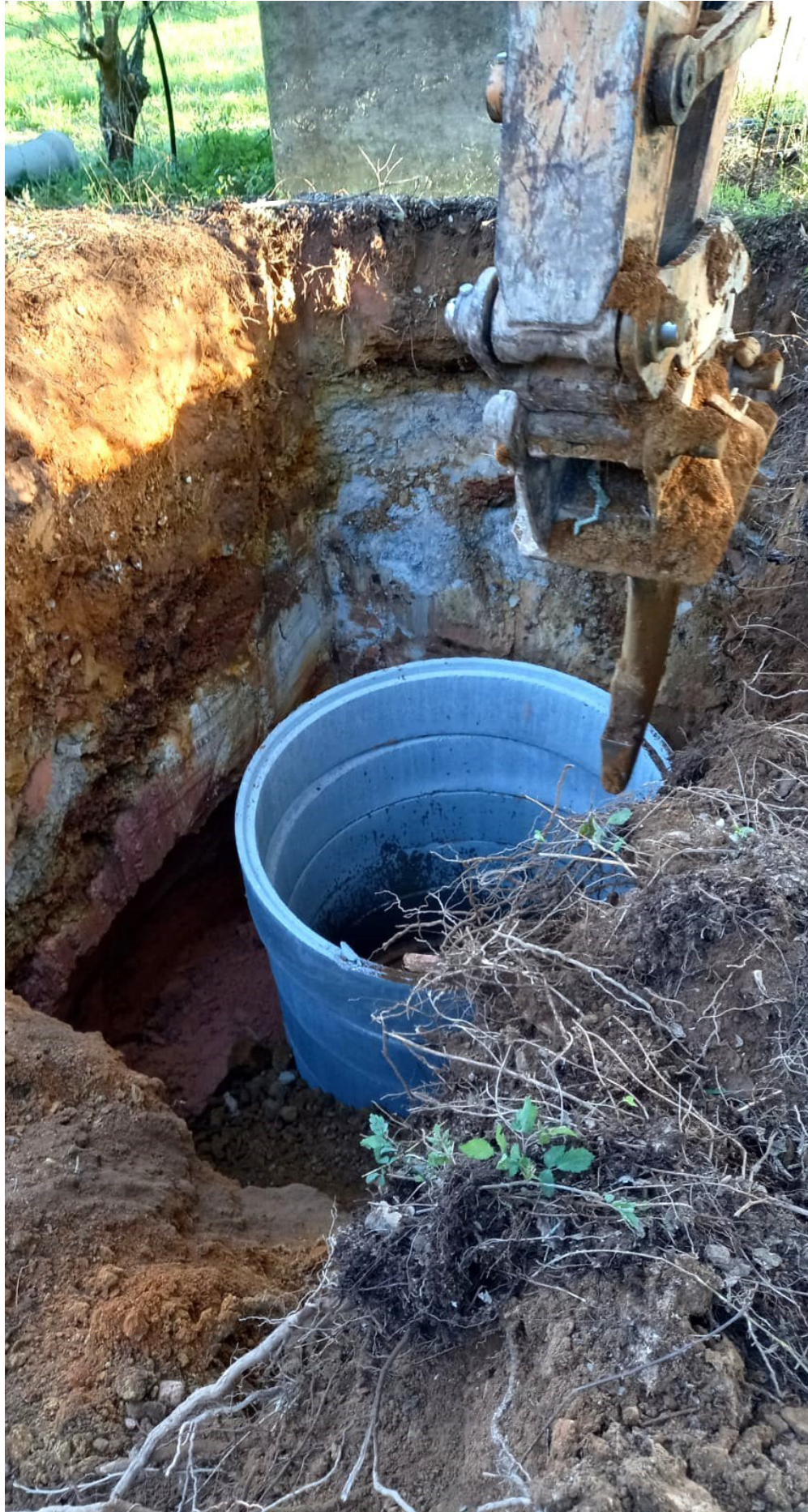
Fig 41. Construção de um poço na Sarnada.
