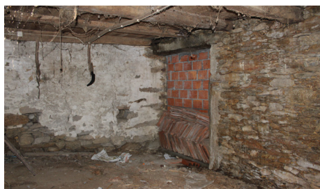
15 | Acesso à fonte fechado no piso inferior da Casa Nova,
