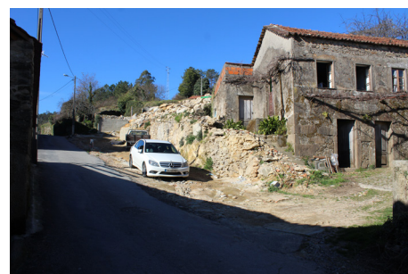
80 | Obras de alargamento da ligação principal entre o lugar de Dornelas e Silva Escura, Rua da Chapadinha.
