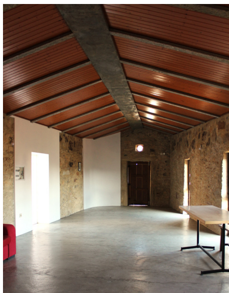
86 | Interior da habitação reabilitada pela população à frente da Casa, 2021.
