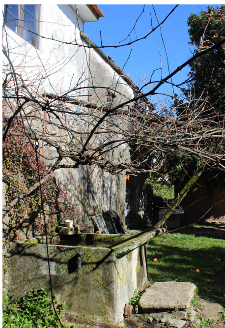
35 | Tanque no Logradouro.
