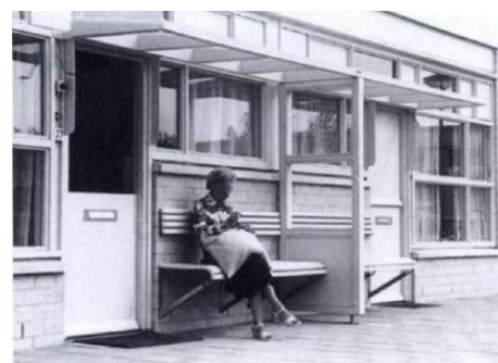
138 | Zona abrigada à frente dos apartamentos que pertencem ao lar De Overloop. Um local para dizer olá ou adeus às pessoas que passam, para se abrigarem. Um alpendre que pertence a dois apartamentos que tem uma divisão, mas permite a comunicação.
