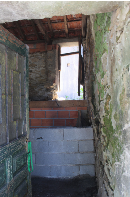
85 | Reabilitação em progresso de uma casa em alvenaria de pedra.
