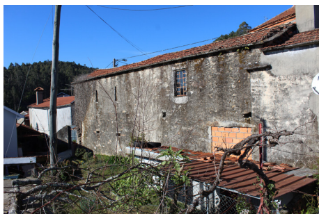
31 | Alçado Sul da Casa Nova.
