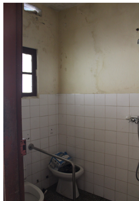
48 | Casa de banho atual.
