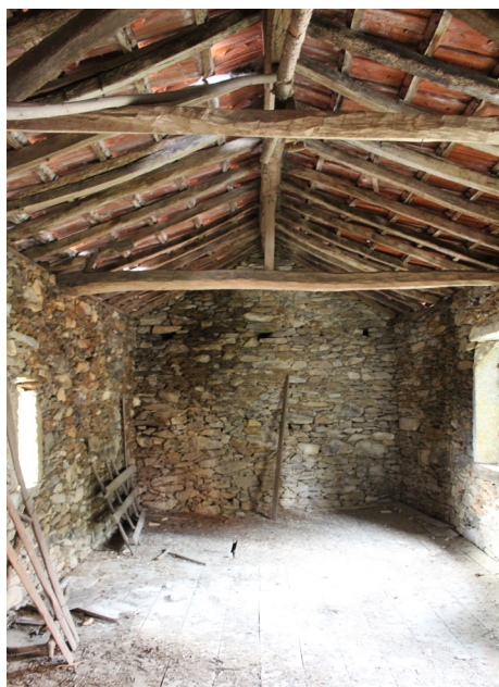
22 | Estrutura vertical em alvenaria de pedra e estrutura horizontal e da cobertura em madeira exposto na Casa Nova.
