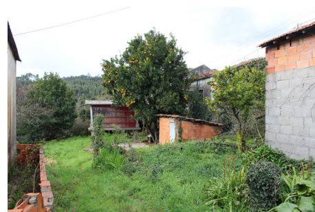
20 | Visto do logradouro a partir do acesso da Largo da Estrada, como canastro e um arrumo.
