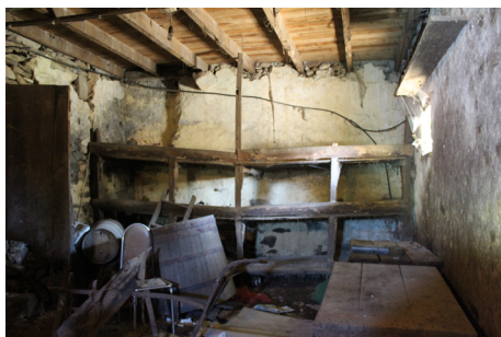
42 | Zona de armazenamento no piso inferior da Casa Principal.
