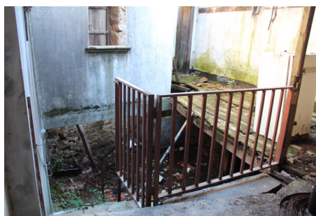
38 | Escadas interiores da Casa do Tear.
