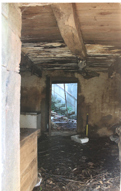
39 | Zona de arrumos no piso inferior da Casa do Tear.
