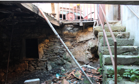
9 | Escada interiores apoiadas num maciço rochoso na Casa do Tear.
