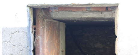
23 | Vista da laje de betão da Casa Principal.
