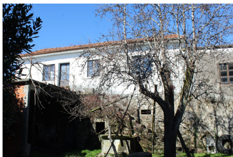
32 | Alçado Sul da Casa Principal e Casa do Tear.
