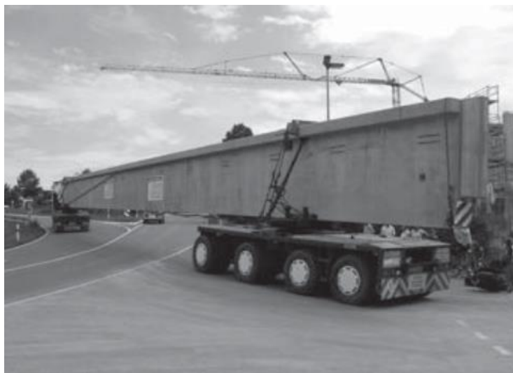
Fig. 2.2 - Transporte de um elemento pré-fabricado [4]
