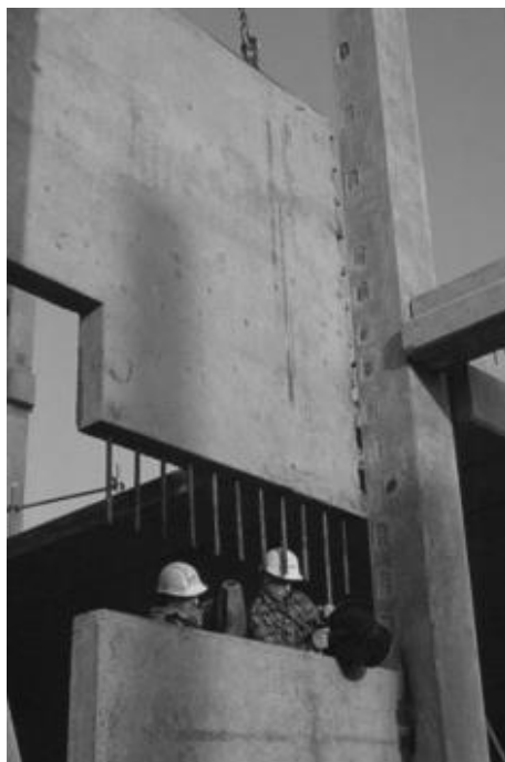
Fig. 2.8 - Exemplo de uma parede pré-fabricada e respetiva ligação [6]
