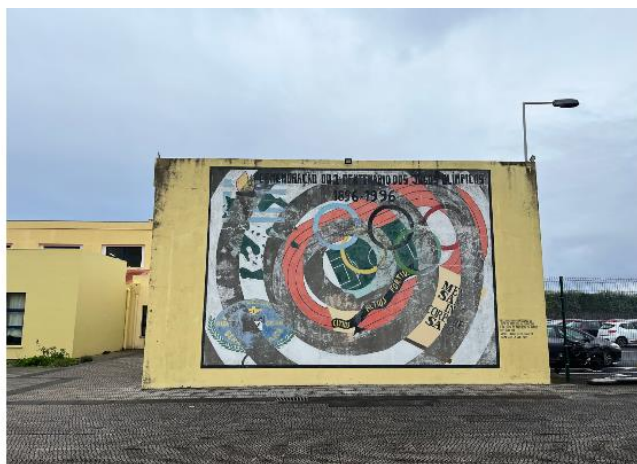
Figura 71: Estado da parede prevista
