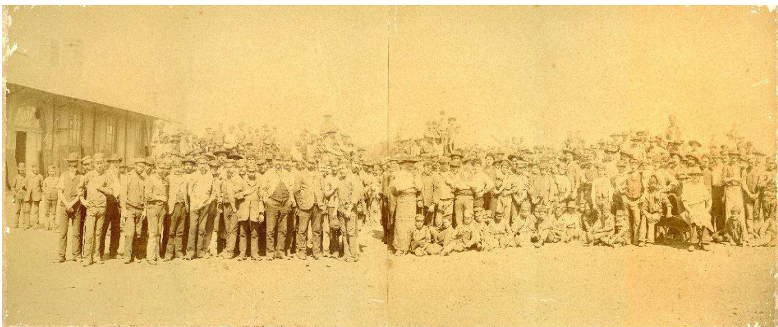
Figura 19 - Operários e engenheiros envolvidos na construção do aterro para a nova gare ferroviária (c. 1882).
