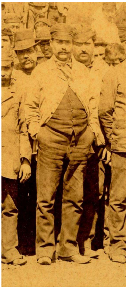
Figura 20 - Pormenor da fotografia anterior com engenheiro Miguel Pais entre os operários (c. 1882).
