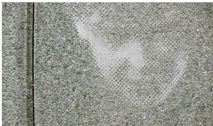
Fig. 123 Detalhe dos painéis de betão na fachada da biblioteca (Janssen, 2013)
