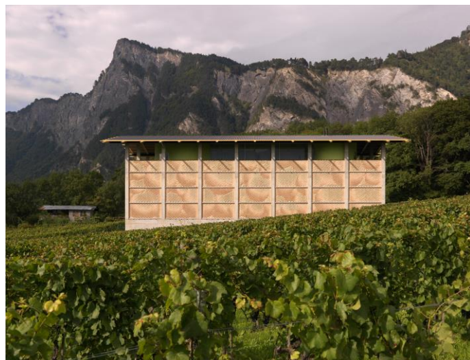
Fig. 32 Adega Gantenbein, Gramazio & Kohler e Bearth & Deplazes Architekten, 2006, Suíça (Feiner, 2012)
