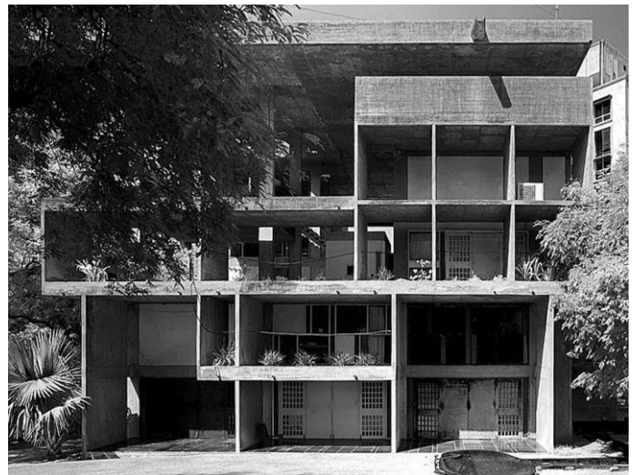
Fig. 3 Fachada posterior da Villa Shodhan, Le Corbusier, 1956, Ahmedabad (Emden, 2012)
