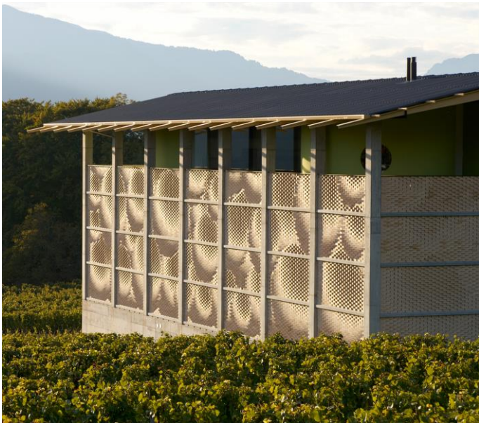
Fig. 22 Adega Gantenbein, Gramazio & Kohler e Bearth & Deplazes Architekten, 2006, Suíça (Feiner, 2012)
