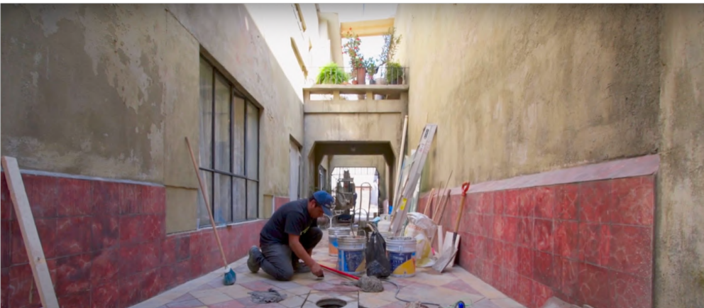
Fig. 30: Cenário de "Roma"(2018) em processo de construção: aplicação dos azulejos
