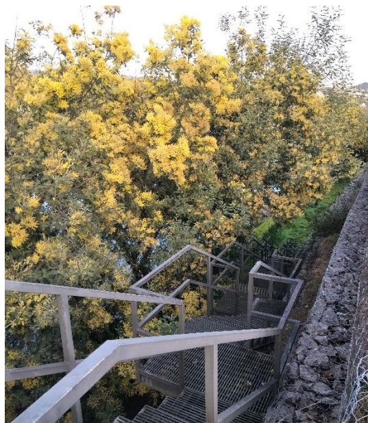
Figura 40. Escadas existentes. (Fonte: Autor)
