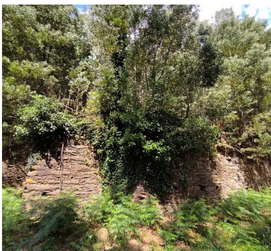
Figura 49. Muro de pedra. (Fonte: Autor)
