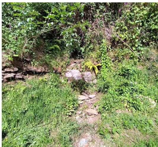
Figura 50. Muro de pedra. (Fonte: Autor)
