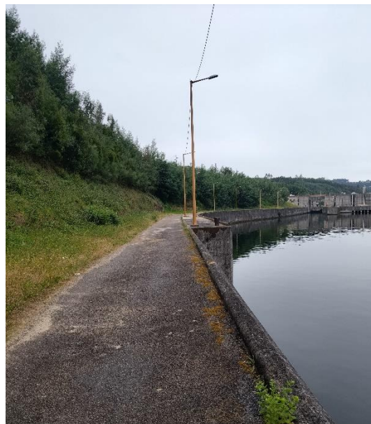
Figura 32. Muro existente. (Fonte: Autor)
