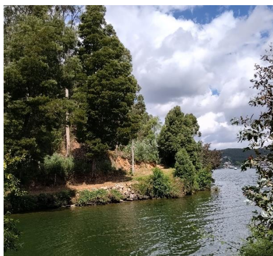
Figura 48. Muro de pedra. (Fonte: Autor)
