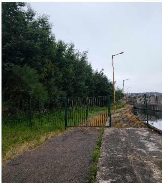
Figura 31. Vedação existente. (Fonte: Autor)
