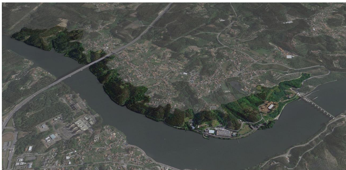
Figura 26. Área de Intervenção. (Fonte: Autor)
