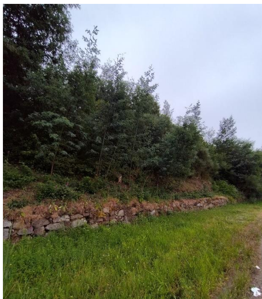
Figura 33. Muro em pedra. (Fonte: Autor)
