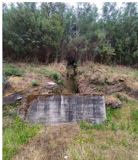
Figura 34. Muro existente. (Fonte: Autor)
