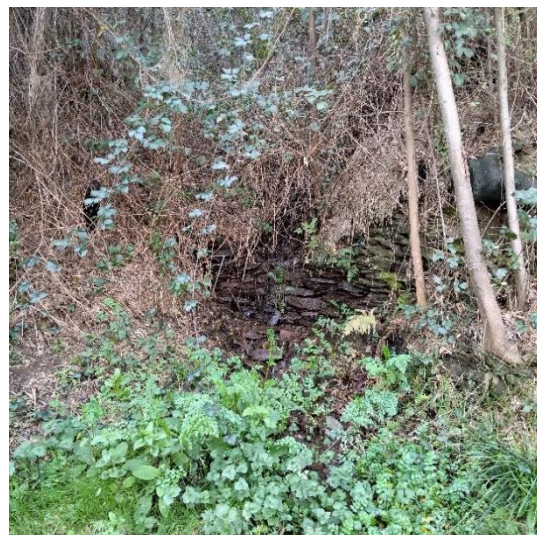
Figura 68. Muro em xisto. (Fonte: Autor)
