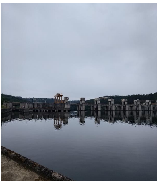
Figura 29. Barragem de Crestuma-Lever. (Fonte: Autor)
