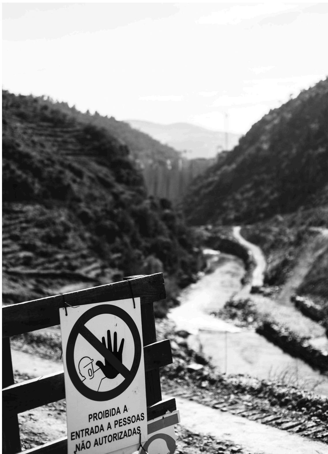
[ 16 ] pela Linha do Tua, a barragem ao fundo, ainda em construção, março de 2016.
