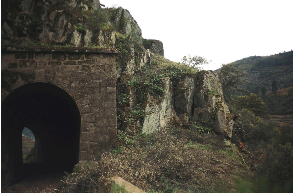
[ 11 ] túnel das Presas talhado nas rochas da íngreme encosta, março de 2016.
