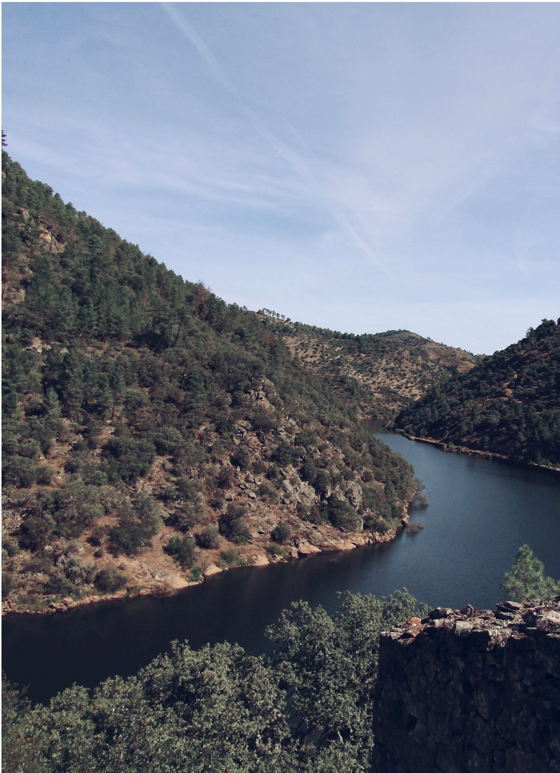
[ 18 ] nível da água depois da barragem esta em funcionamento, agosto de 2023.
