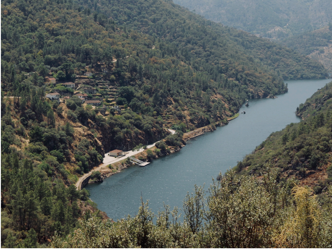
[ 20 ] vista para São Lourenço depois da barragem estar em funcionamento, julho de 2022.
