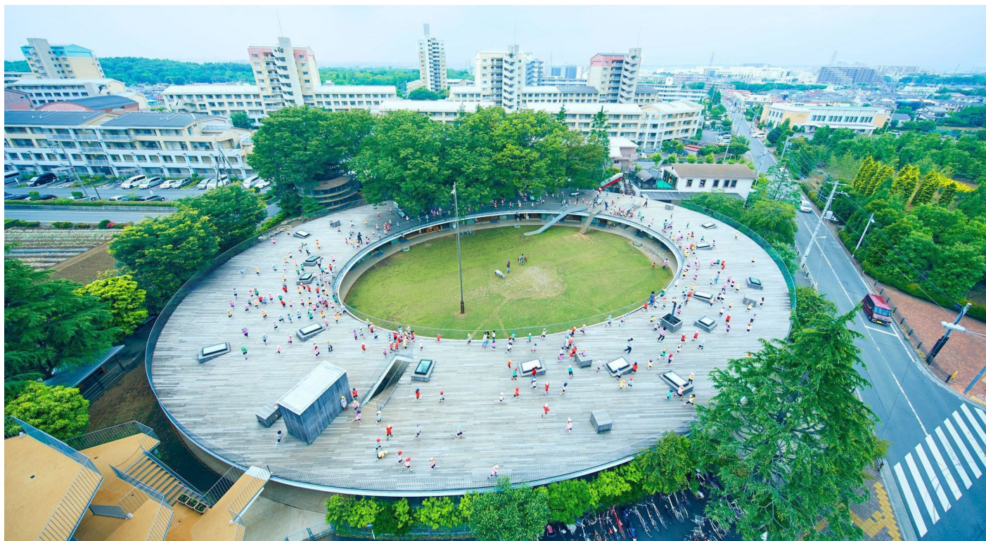
Fig. 54 - A cobertura circular é o local perfeito para as brincadeiras das crianças no exterior, onde, segundo o arquiteto, as crianças correm sem parar e percorrem distâncias inusitadas, do interior para o exterior, do nível térreo, para a cobertura.
