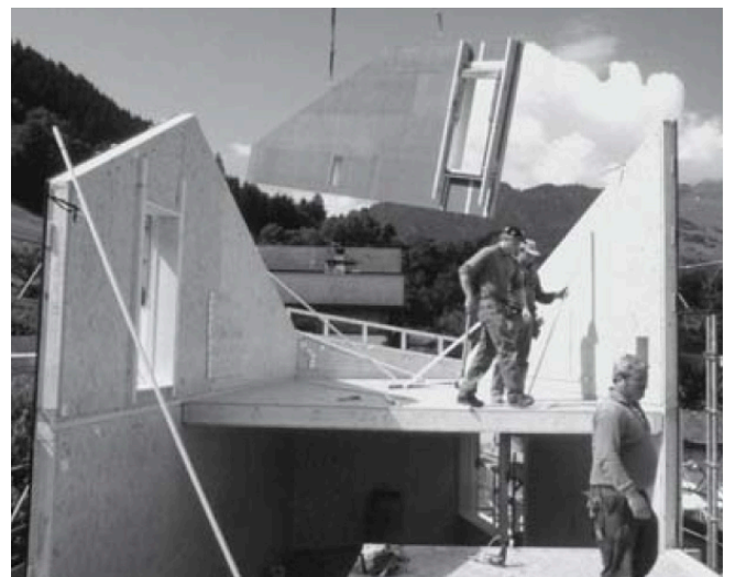
Fig. 23 - Colocação dos mesmos elementos pré-fabricados na obra Tower House .
