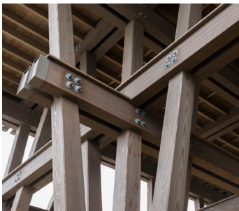
Fig. 39 - Pormenor do sistema estrutural que eleva os volumes do terreno.
