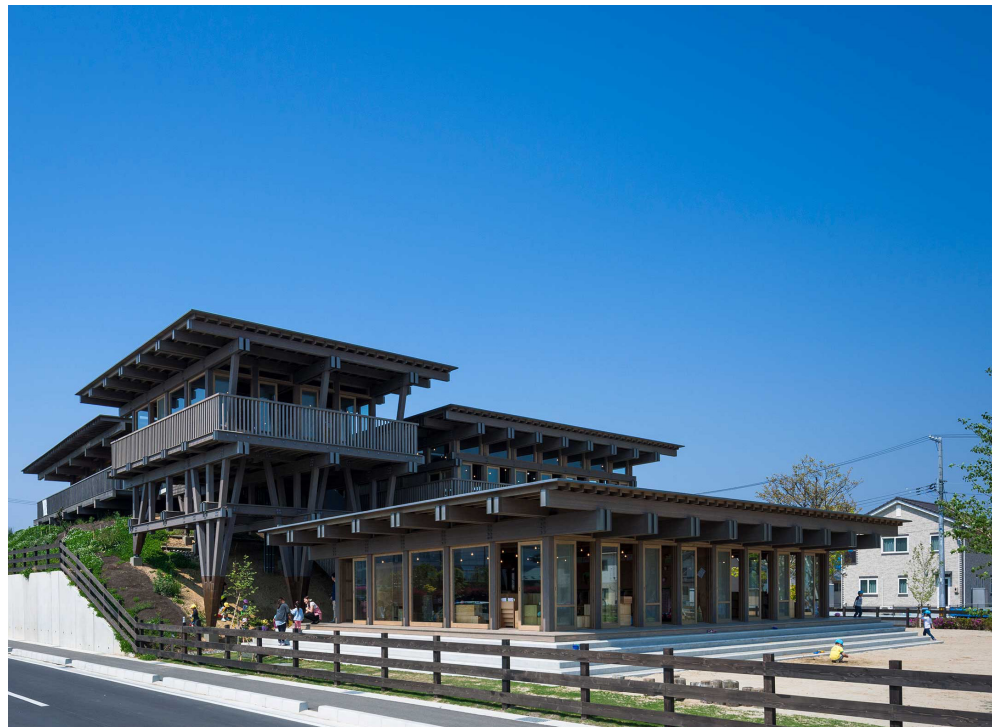
Fig. 39 - Pormenor do sistema estrutural que eleva os volumes do terreno.
