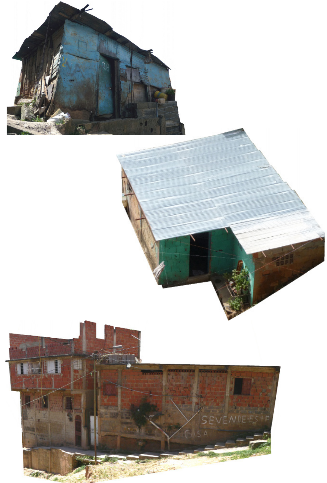
71. Tipologia de habitações em três fases de construção diferentes.
