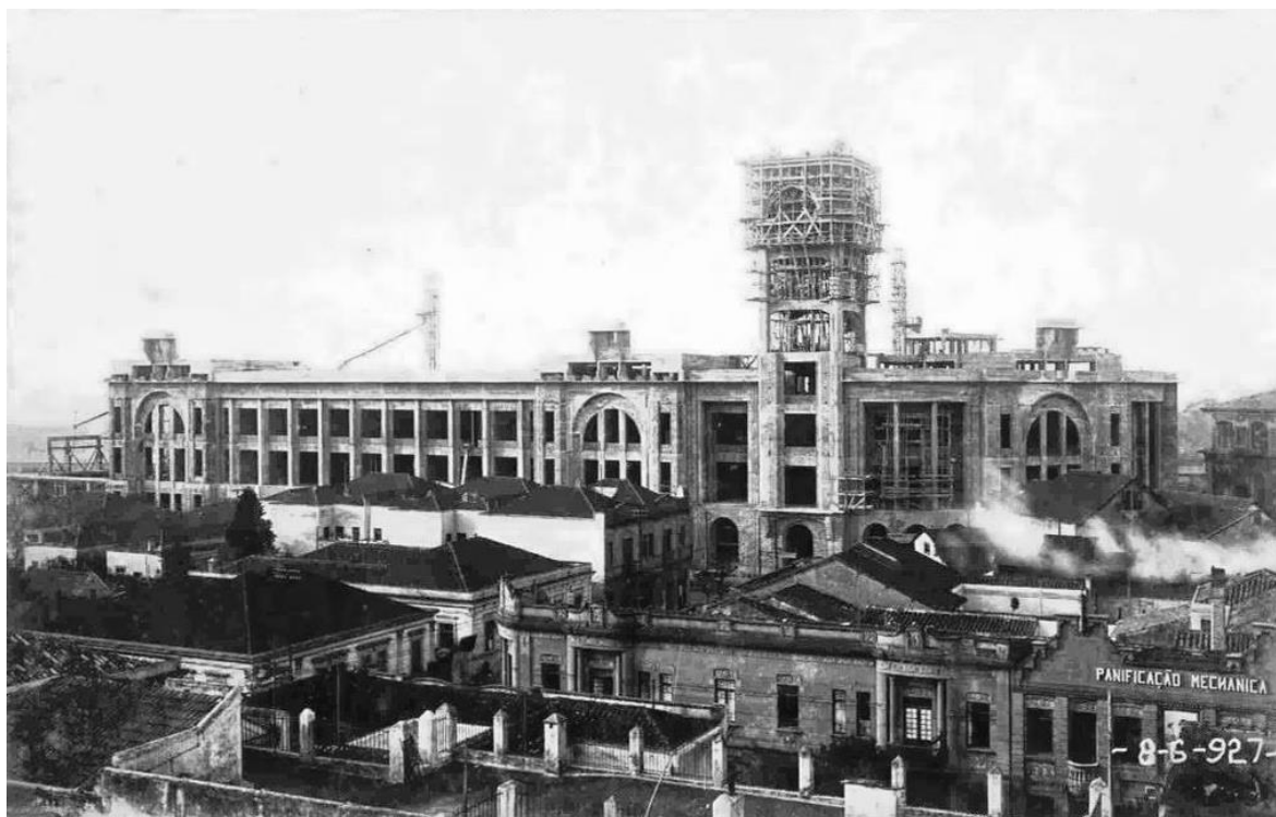
IMAGEM 25: Construção da Estação Júlio Prestes | São Paulo – 1925 – 1938 Disponível em: https://arquivo.arg.br/projetos/estacao-julio-prestes#&gid=1&pid=4 (acesso em 15 de dezembro de 2020)
