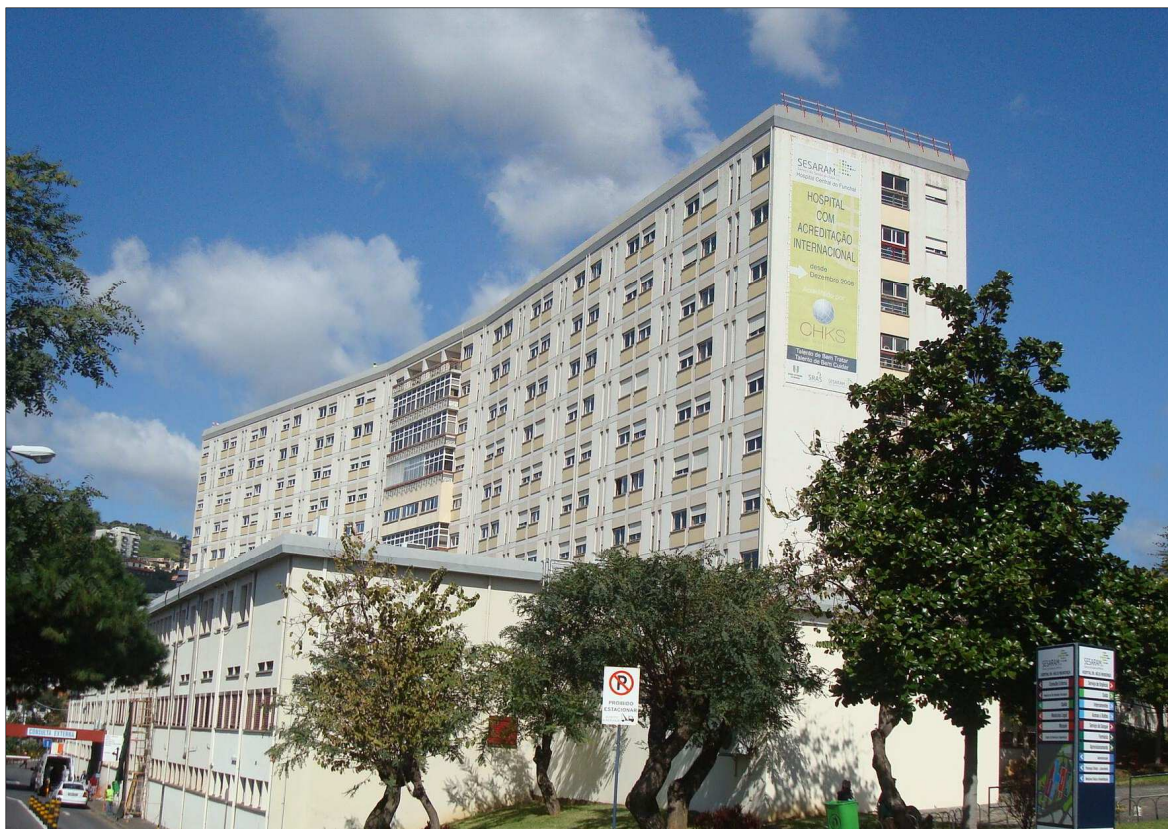
Figura 1 – Fachada sul do Hospital Dr. Nélcio Mendonça
