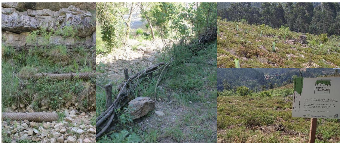
Figura 25 - à esquerda, estratégia de contenção das margens recorrendo ao biorolo; ao centro, contenção de margens recorrendo ao entrancado; à direita, área de intervenção do projeto Metro Quadrado; Fotos: Maria Nóbrega Dias e Raquel Viterbo
