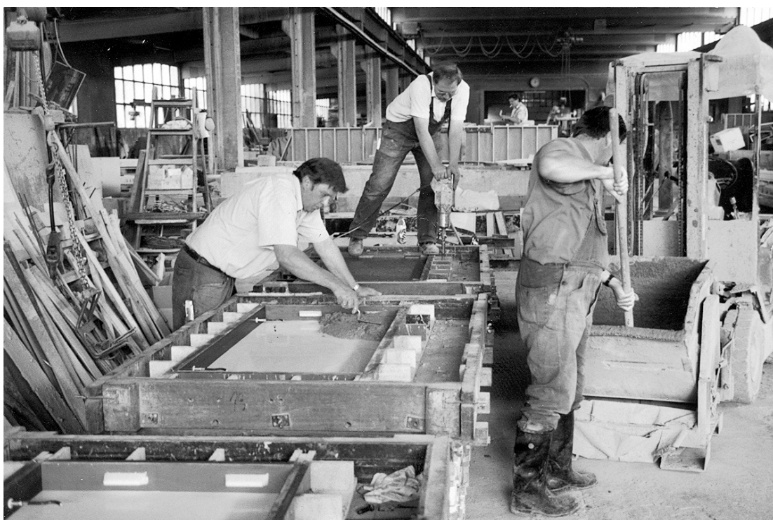
56. Pré-Fabricação dos Painéis para a fachada da Eberswalde Technical School Library, Herzog & de Meuron, 1994-99
