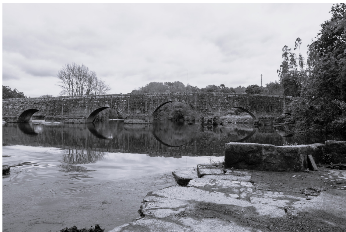
Figura 7 - Ponte D. Zameiro
