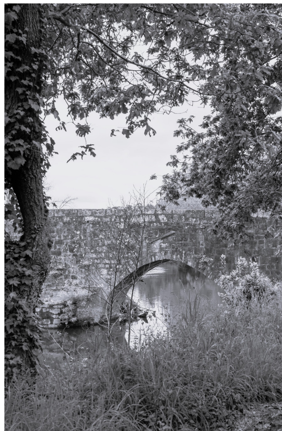
Figura 6 - Ponte D. Zameiro
