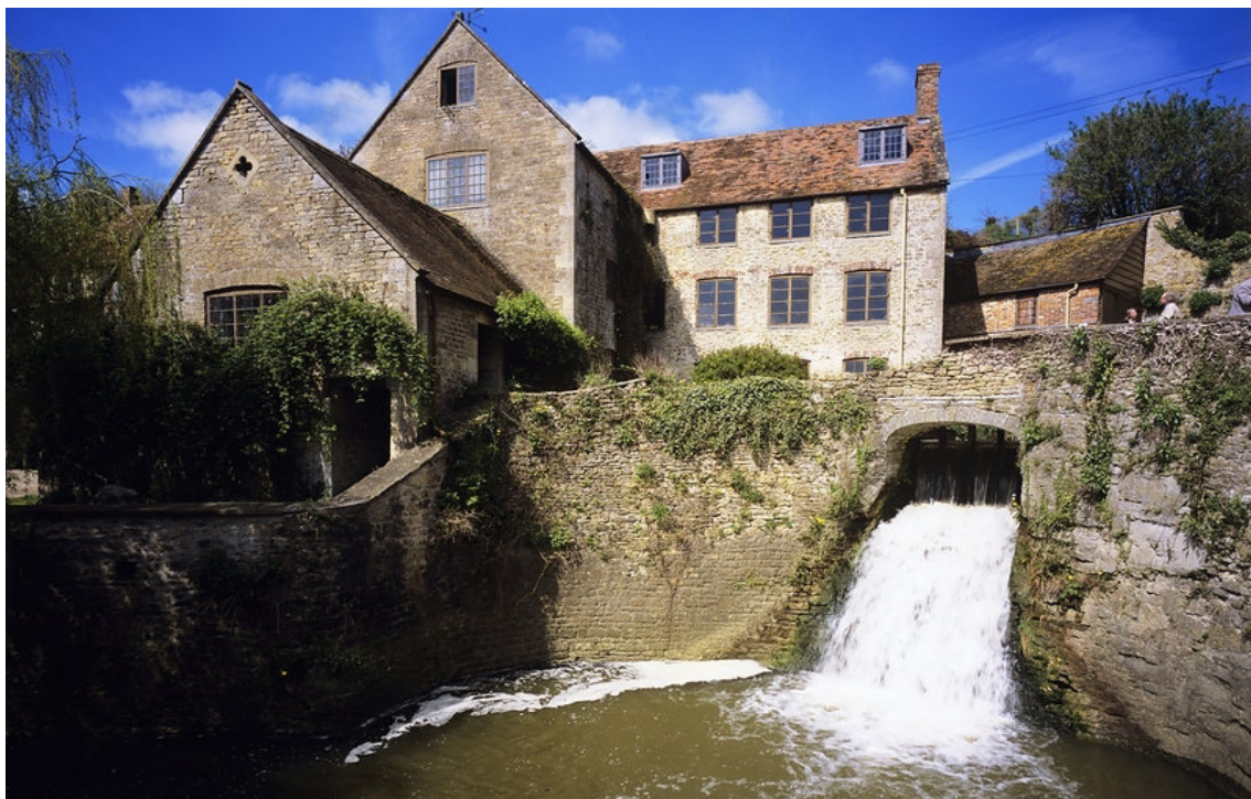
Figura 35 - Moinho de Gants, Bruton, Somerset, Reino Unido Em 2003 a roda deste moinho foi transformada para a produção de energia, com uma potência de 12kW.
