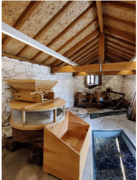
Figura 46 - Moinho de São Marçal Intervenção Interior
