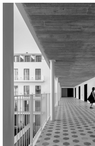
B.6.2 1. Fotografia da Fachada Oeste do Edifício
