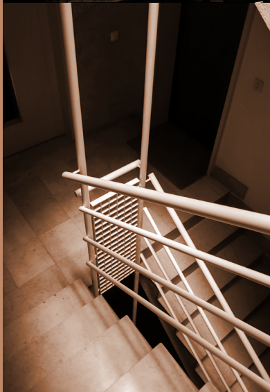
Fig. 63 Escada comum do Edifício de habitação na Rua do Teatro, Porto, Eduardo Souto Moura, 1995
