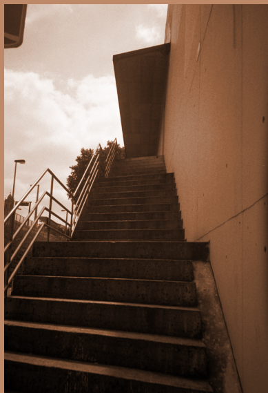
Fig. 100 Escada Comum Norte do Bairro da Bouça, Porto, Álvaro Siza, 1973 - 2006
