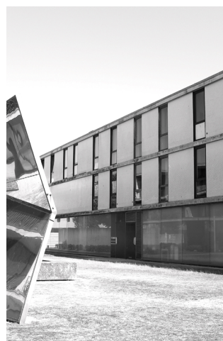
B.3.2 1. Fotografia da Fachada Sul do Edifício
