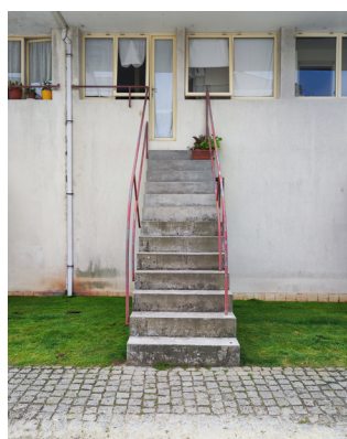
B.2.1 18. Escada Exterior do Fogo
