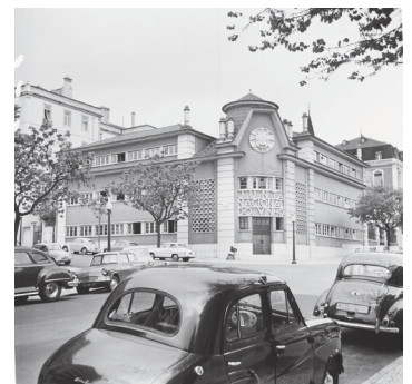
138. Edifício da sede da JNV, em Lisboa, projeto de Cassiano Branco, 1942.
