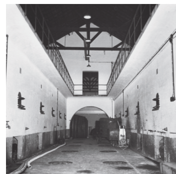
112. Corredor dos depósitos da adegas cooperativa de Pinhel
