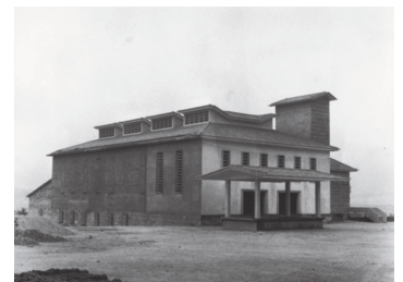
151 e 152. Adega cooperativa da Covilhã, ARS arquitetos, 1957
